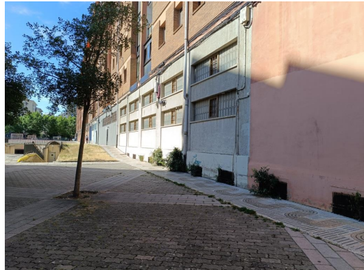
FOTO FACHADA TRASERA. CALLE SAN ROQUE
