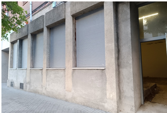
FOTO FACHADA PRINCIPAL. CALLE VIRGEN DEL PUY
