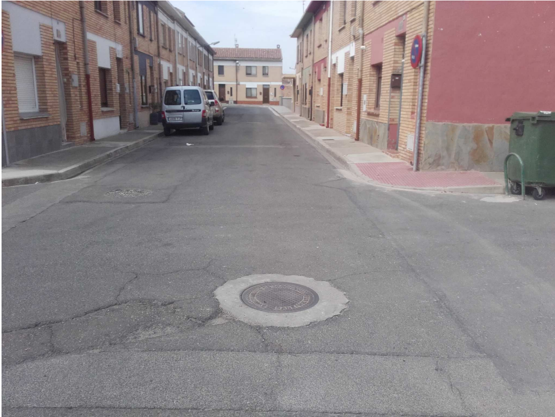
Fotografía 2: c/ Guirlanda desde cruce c/ Navas de Tolosa en dirección al pozo PR-03.
