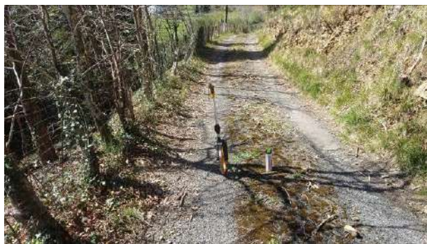
Foto 7: Caserio Xaiundu a mejorar el asfalto
