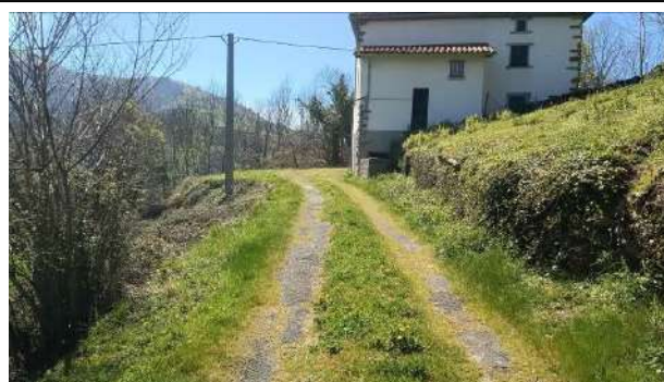
Foto 6: Caserio Xaiundu a mejorar el asfalto
