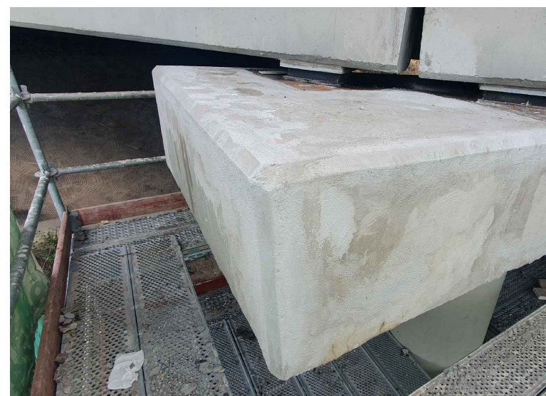
VIGAS Y DINTTEL REPARADOS
