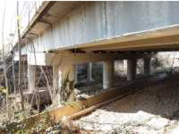
apoyos p2 buen estado
