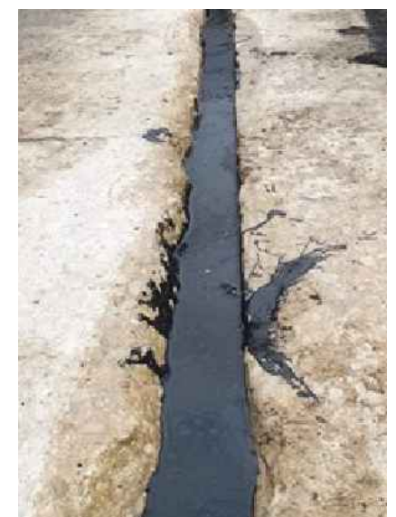
RECONSTRUCCIÓN DE ESTRUCTURAL LABIOS JUNTAS (SUPERIOR)
