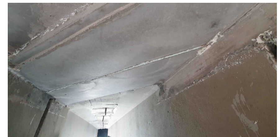
RECONSTRUCCIÓN DE ESTRUCTURAL LABIOS JUNTAS (INFERIOR)
