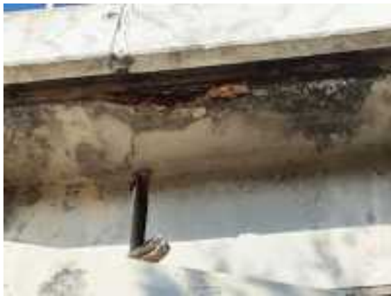
viga 1 sobre p1
