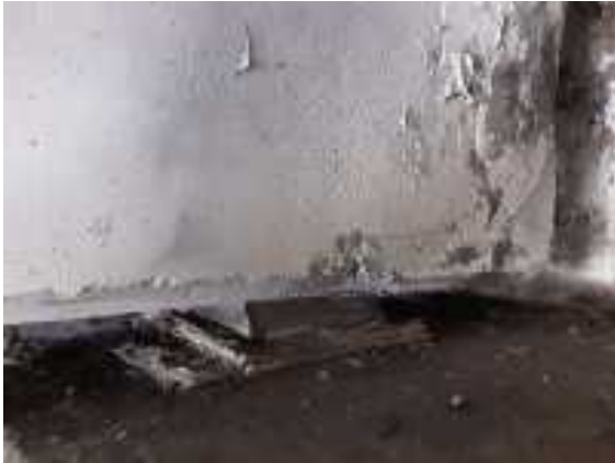
viga 6 sobre e2
