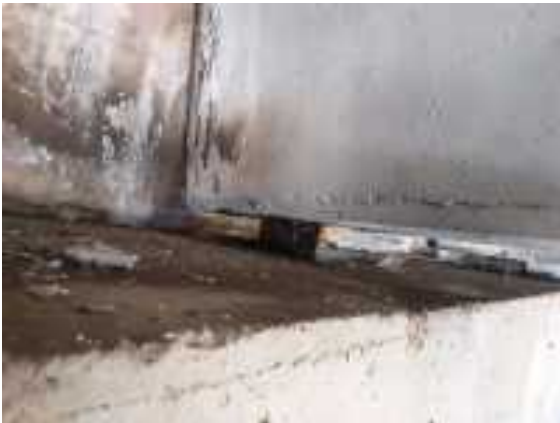
viga 2 sobre e2
