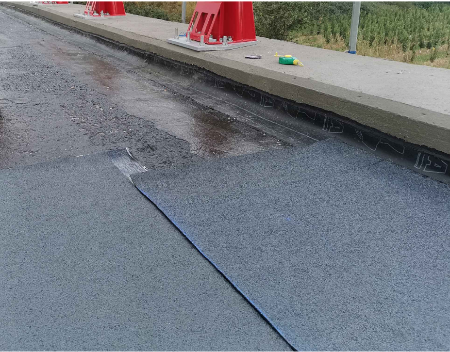
IMPERMEABILIZACION DEL TABLERO CON LÁMINA ASFÁLTICA
