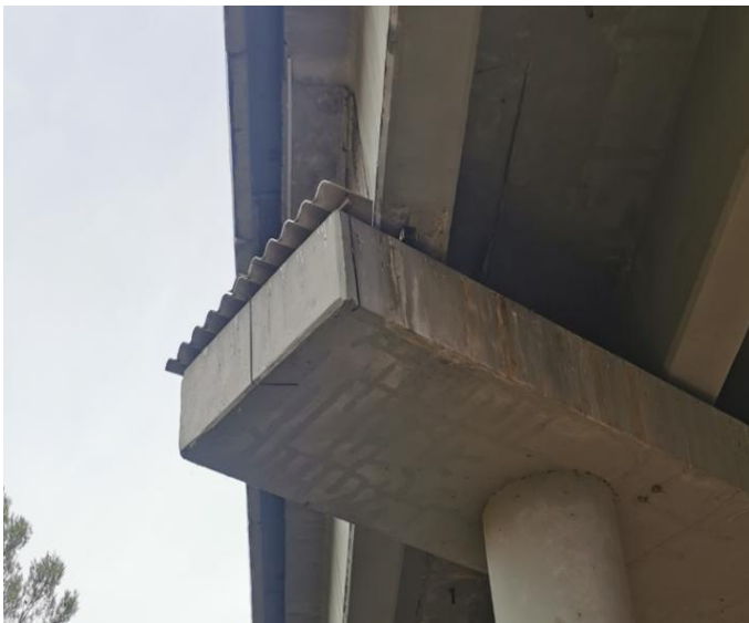
Aspecto de cargadero y cabezas de viga protegidas con membrana cementosa y superficie de cargadero protegido con faldón de chapa inoxidable
