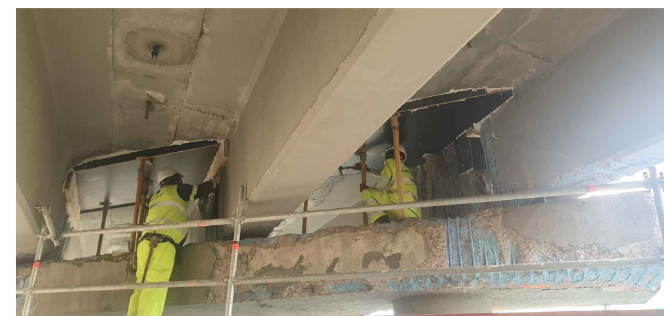
ENCOFRADO INFERIOR EN ZONA DE JUNTAS
