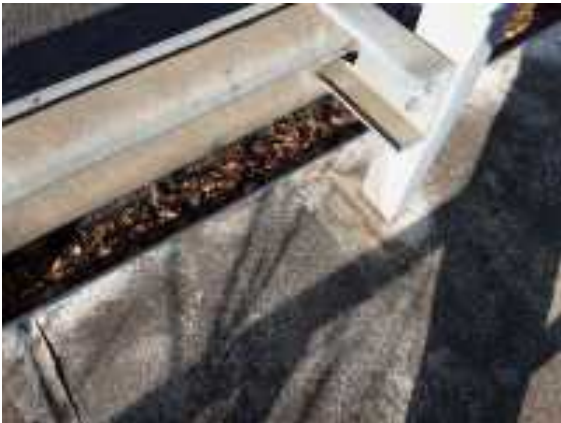
zona anclaje bionda
