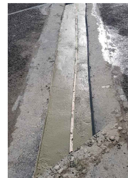
RECONSTRUCCIÓN DE ESTRUCTURAL LABIOS JUNTAS (SUPERIOR)
