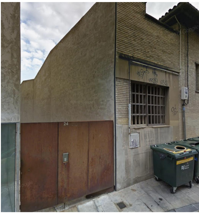
DETALLE DEL ACTUAL ARMARIO PARA G-4 Y LA VENTILACIÓN DE SALA DE CALDERAS.
