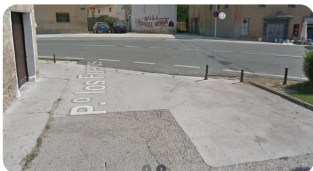
F3 Curva Pk 16+535 NA-1110 previa hundimiento (maps)
