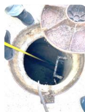
F24 Registro fecales CR Mendigorria y paso alumbrado
