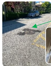
F12 Registro de la general reparto tfno en calzada
