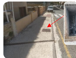
Foto 26 Rejilla y soterrado electricidad
