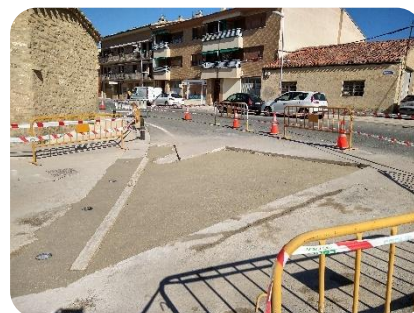
Foto 2: Reposición solera HOR hundimiento
