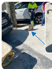
F16 Acom riego repara 2020
