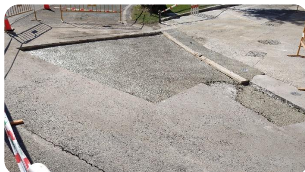
Foto 4 Adecuación hundimiento a rasantes existentes
