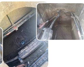
F12 Registro de la general reparto tfno en calzada
