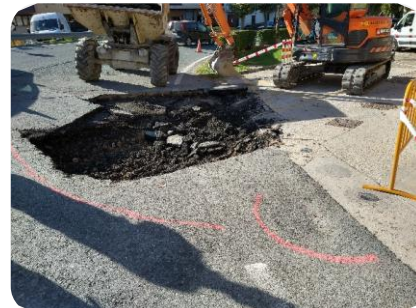
Foto 1: inicio reparaciones hundimiento
