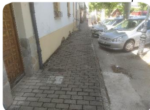
F36 Acceso nivel partición nº10
