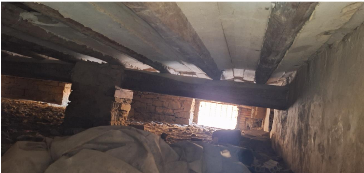
Vista de forjado de suelo de planta baja, aparentemente en buen estado de conservación.
