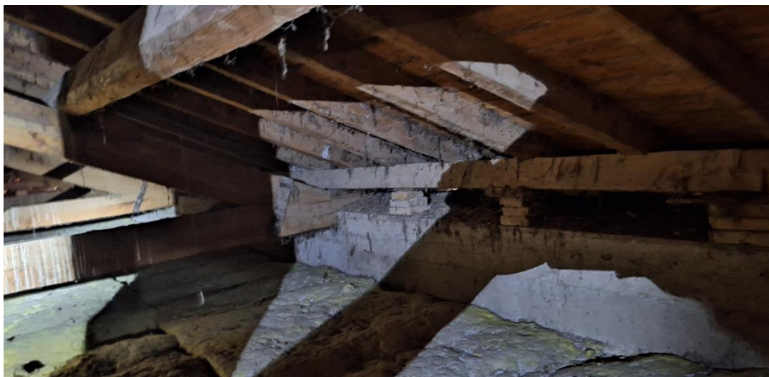
Vista general de la estructura de cubierta
