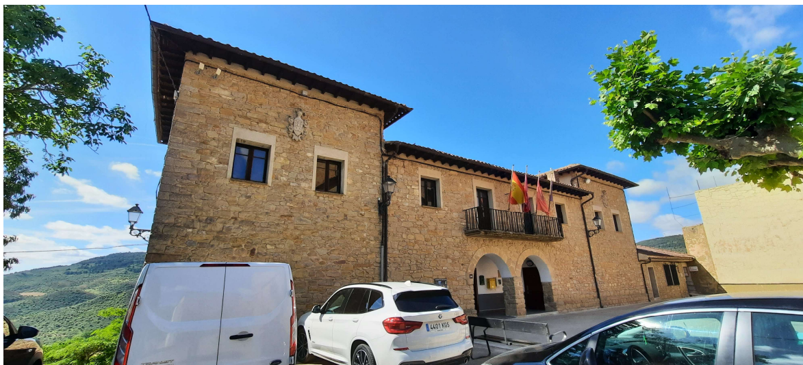
Fachada principal del Edificio Municipal. Planta 1ª, ventanas a cambiar
