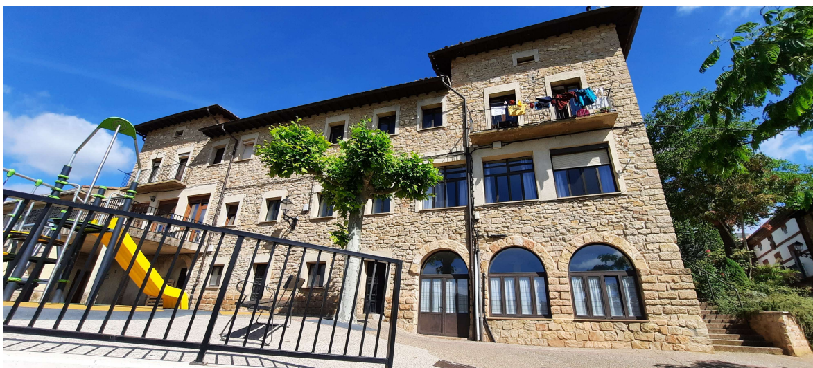
Fachada trasera del Edificio Municipal. Plantas 1ª y 2ª ventanas a sustituir.
