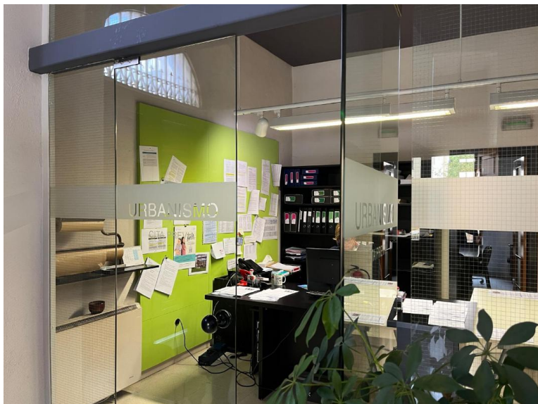
Figura 6: Tabique acristalado entre zona de espera y administración
