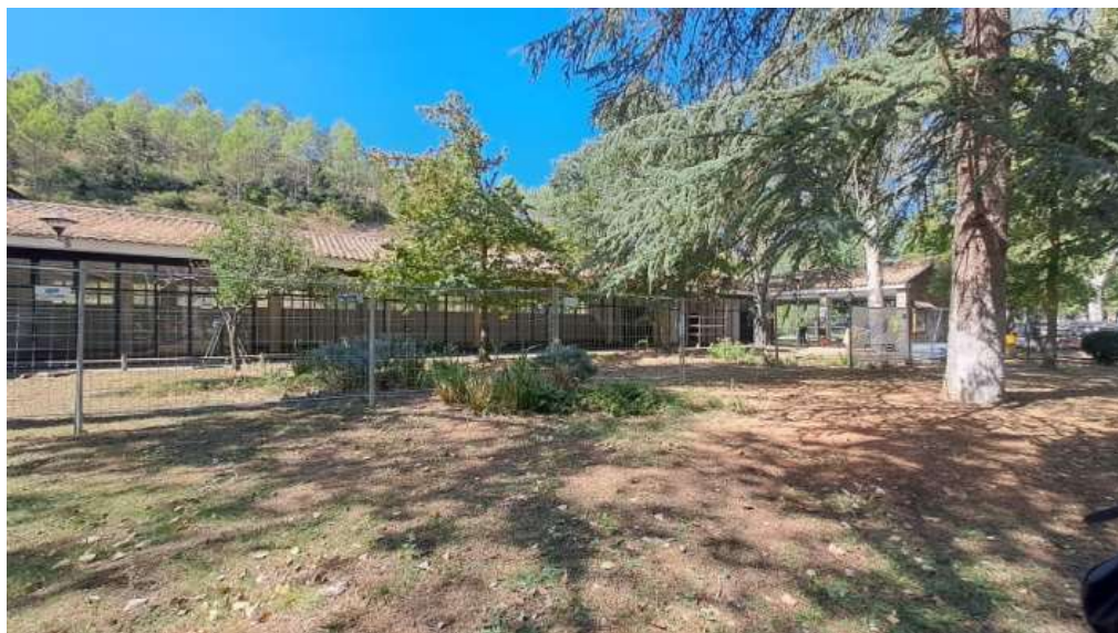
Ámbito de la zona multi-usos (previo a actuales obras)
