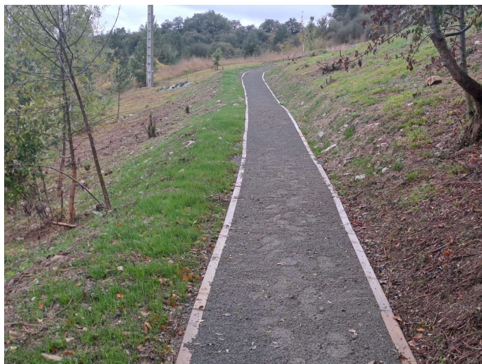
Ejemplo de camino ejecutado con arena ofítica.
