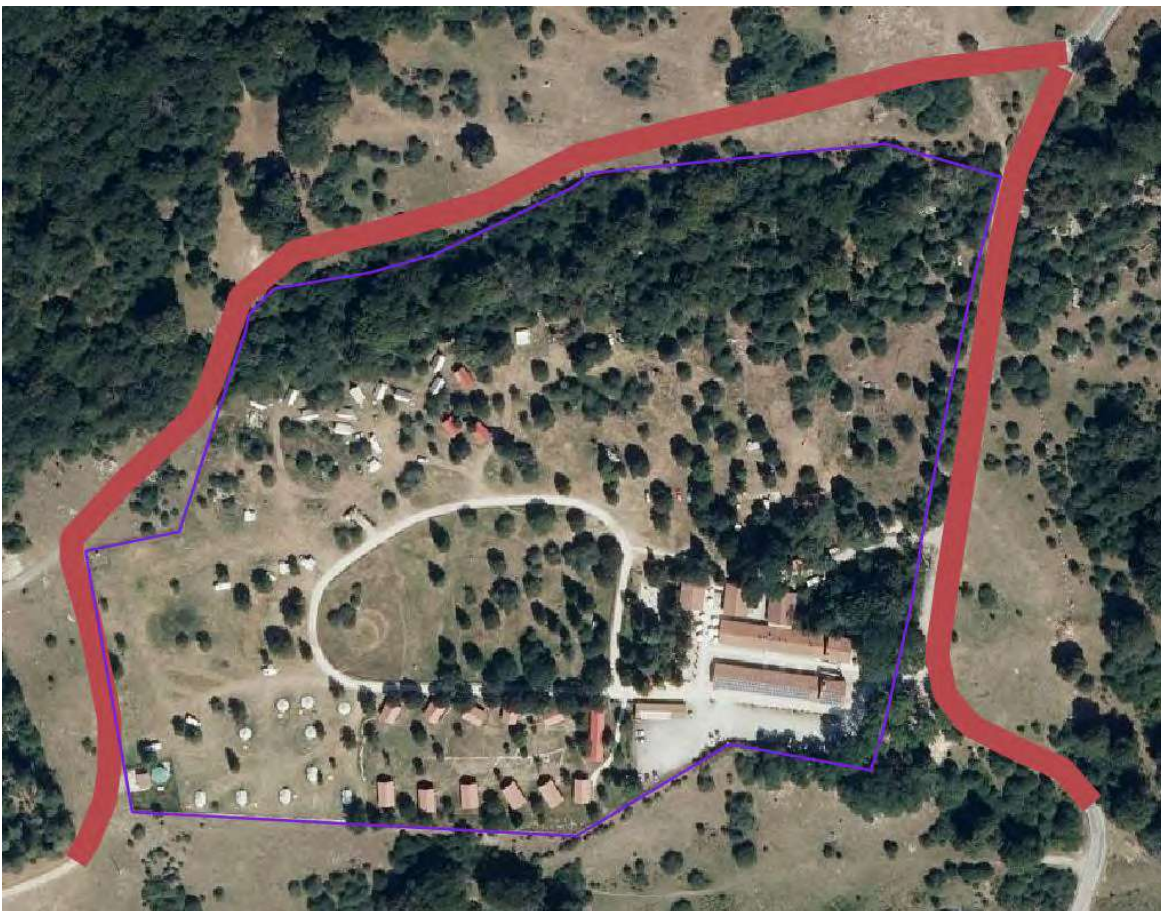
Infraestructuras que hacen de faja
