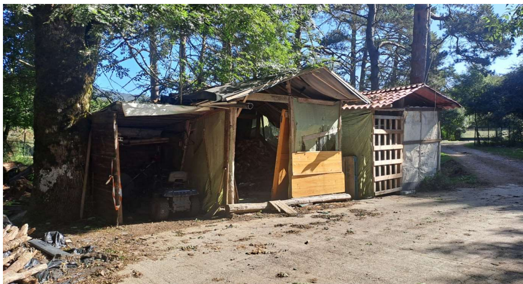
Estado actual de la zona de almacenamiento
