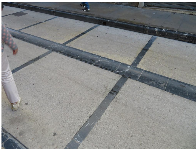
Imagen 2. Detalle de pavimentación existente C/Ruiz de Alda
