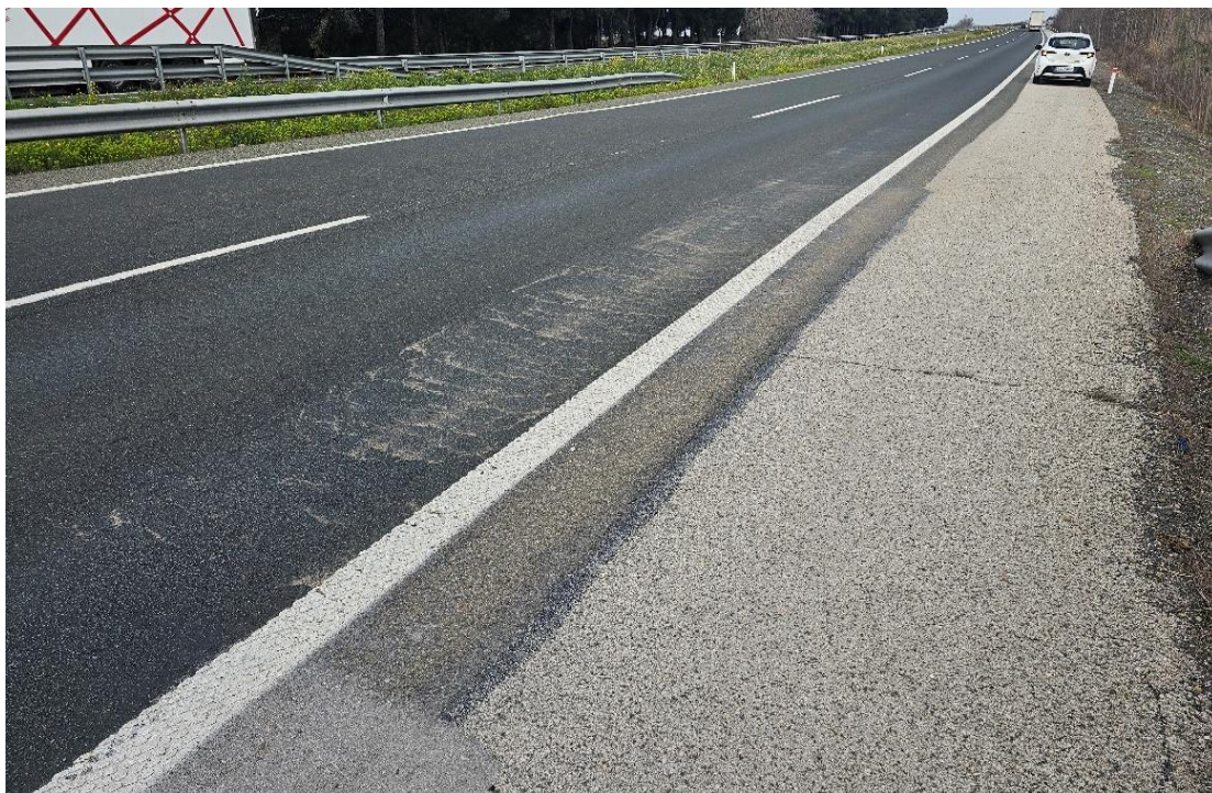
Estado firme Pk 16+400.
