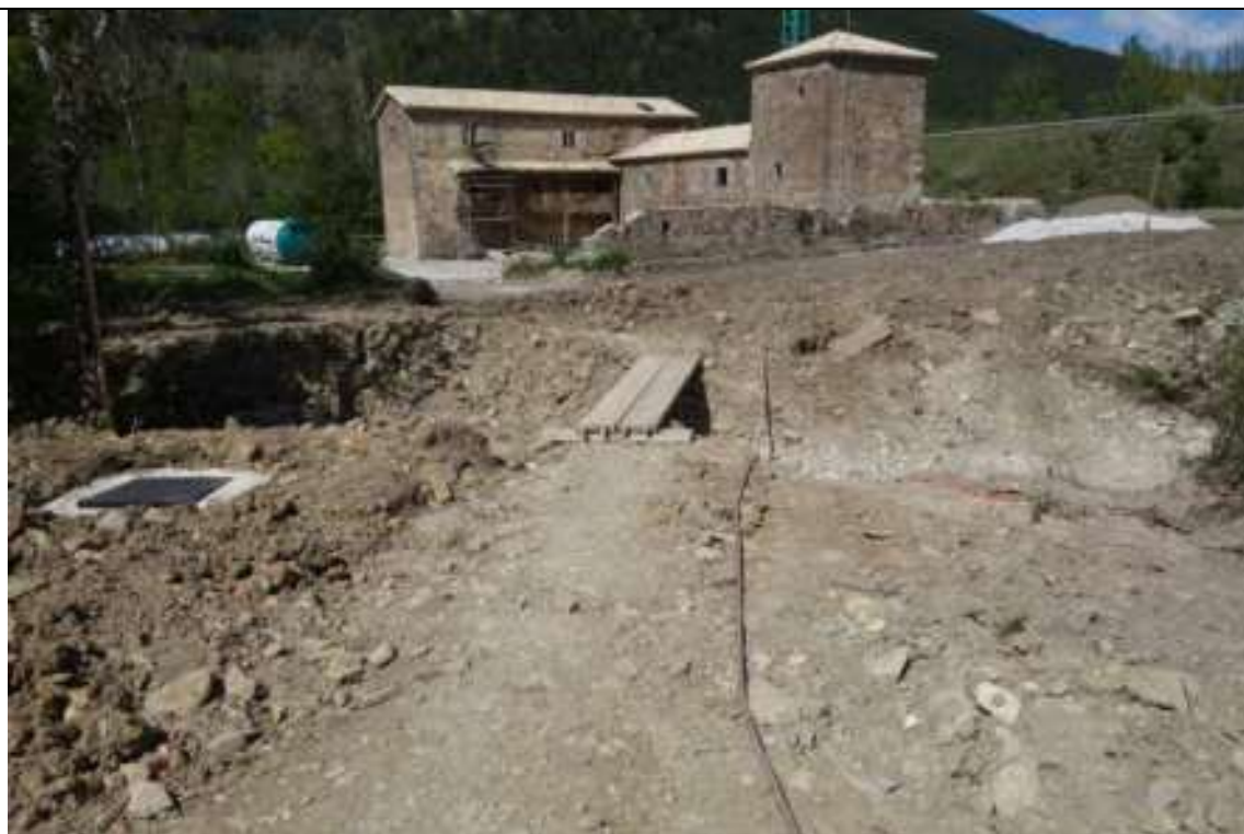
Zona de la regata desprovista de vegetación donde se instalara la pasarela que unirá la Casa del Ermitaño (al fondo) con el Palacio de Arce
