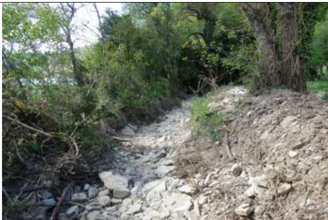
Vista del lecho de la regata hacia aguas abajo. En las márgenes de la regata se observa la orla arbustiva de boj y un fresno bastante grueso
