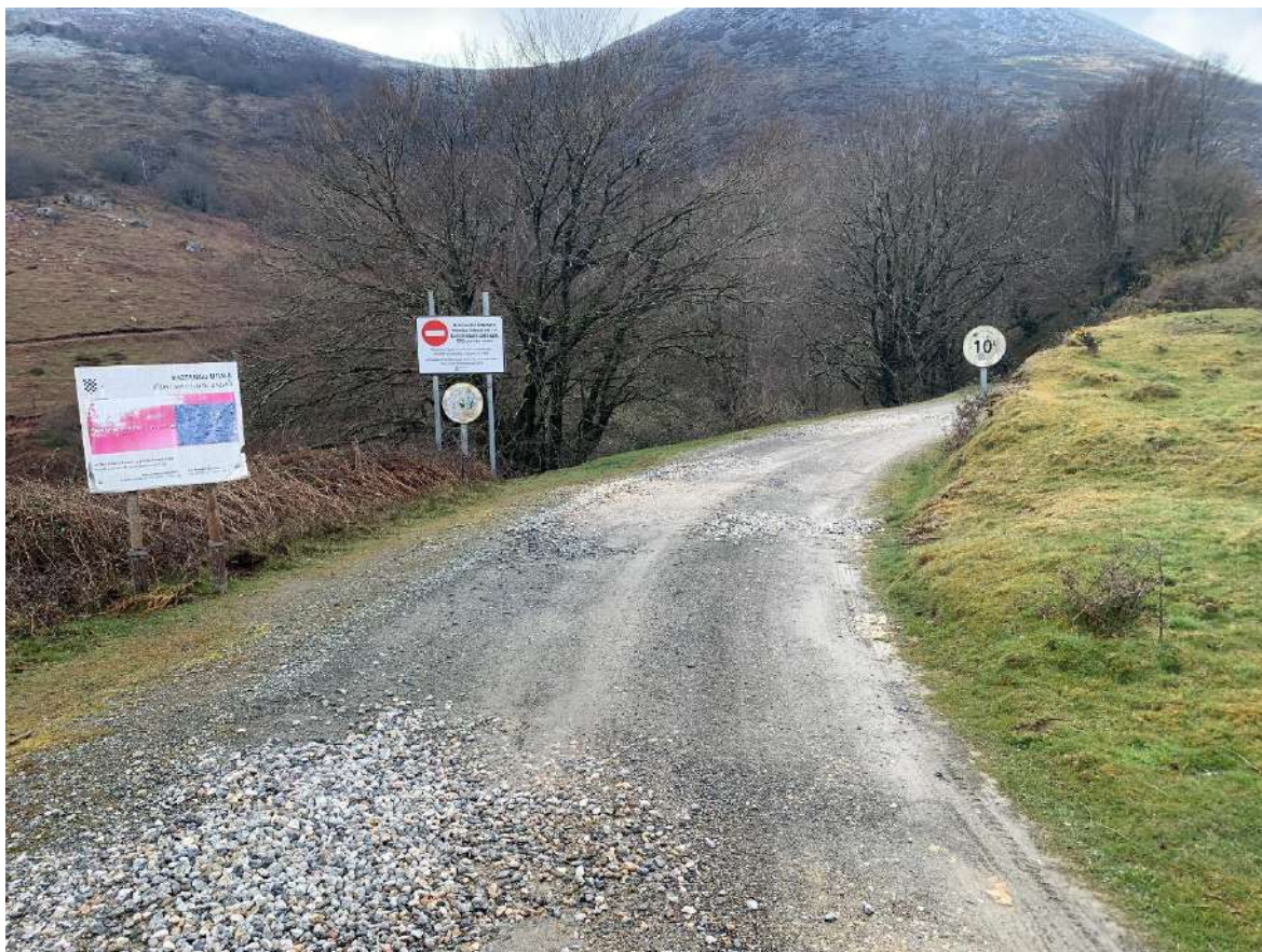
FOTOGRAFÍA 3: Vista general del camino. (Tramo 1)
