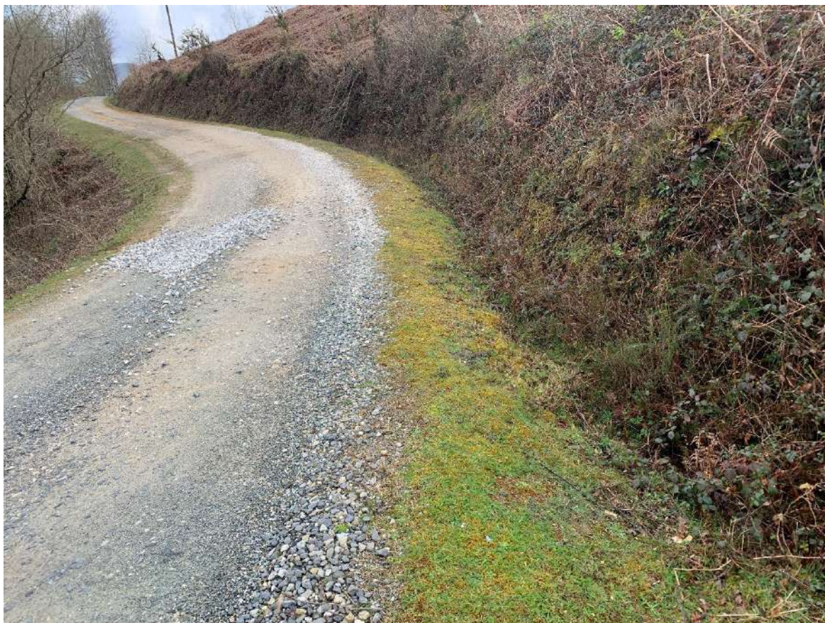
FOTOGRAFÍA 10: Caño a limpiar, Vista general del camino. (Tramo 2)
