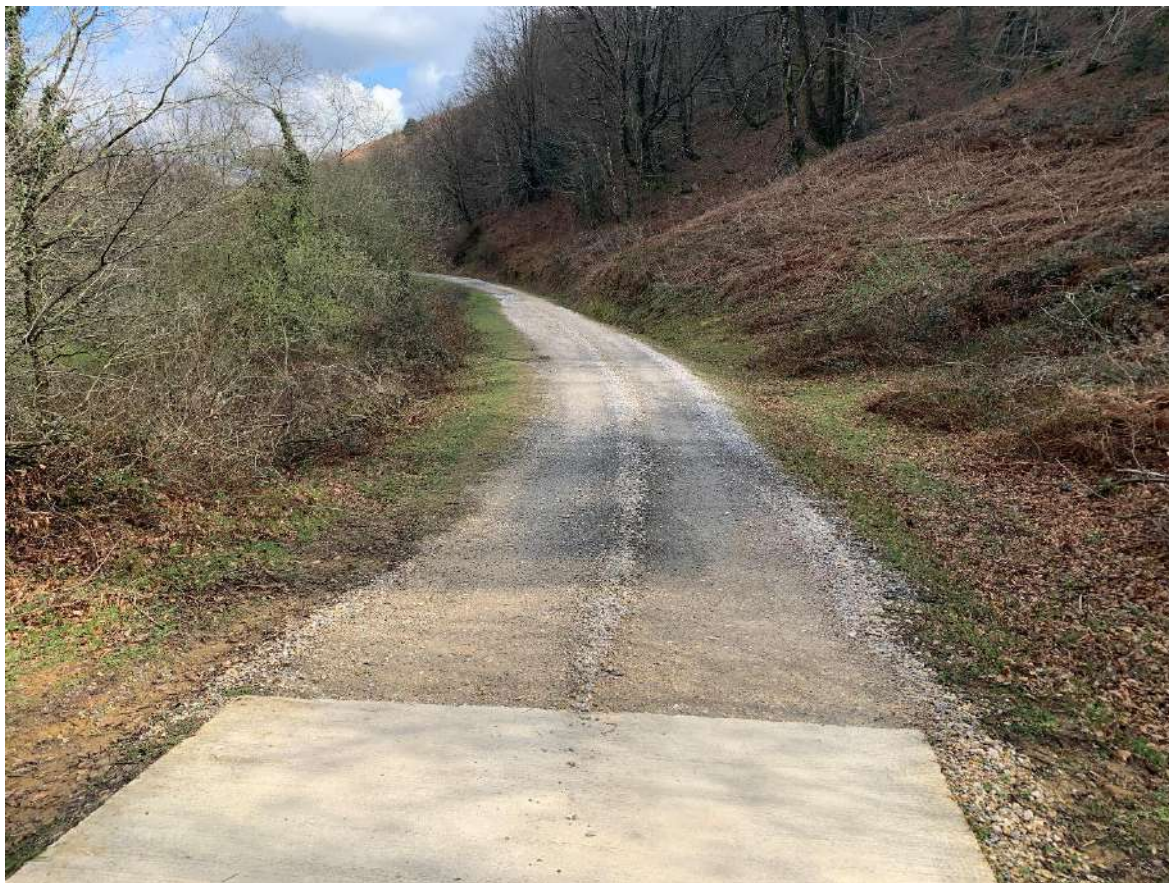
FOTOGRAFÍA 7: Comienzo del Tramo 2 del camino, entronque con hormigón. (Tramo 2)
