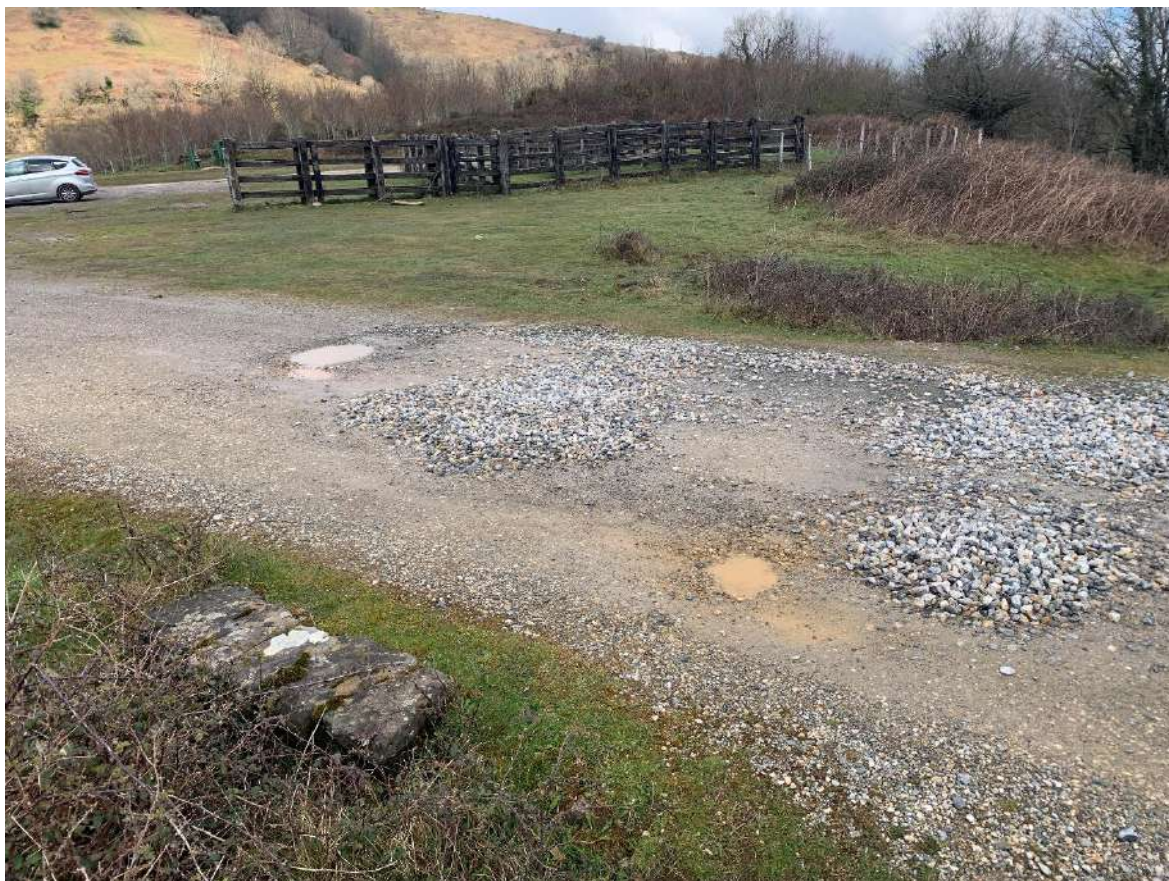
FOTOGRAFÍA 2: Caño a limpiar. (Tramo 1).
