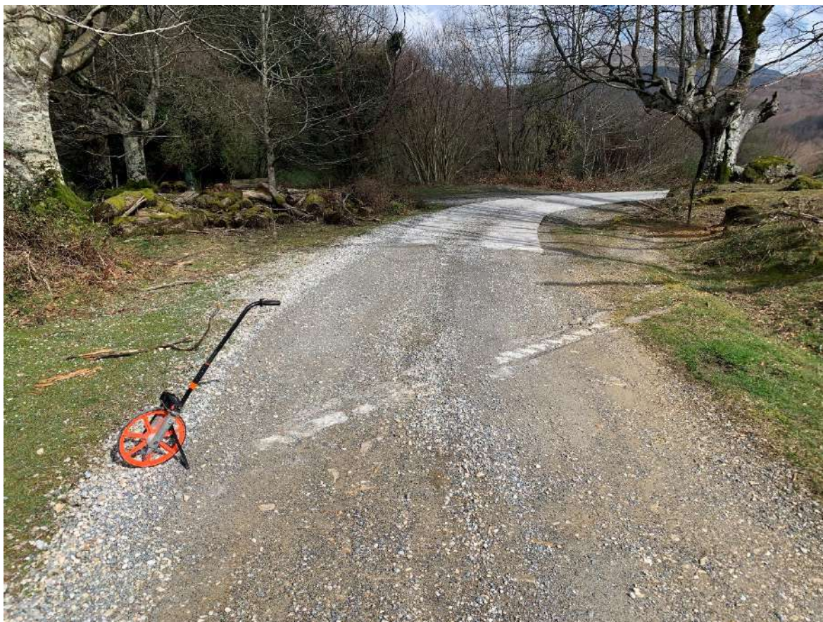
FOTOGRAFÍA 12: Corte de agua a eliminar, llegada a zona de hormigón. Fin del Tramo 2.
