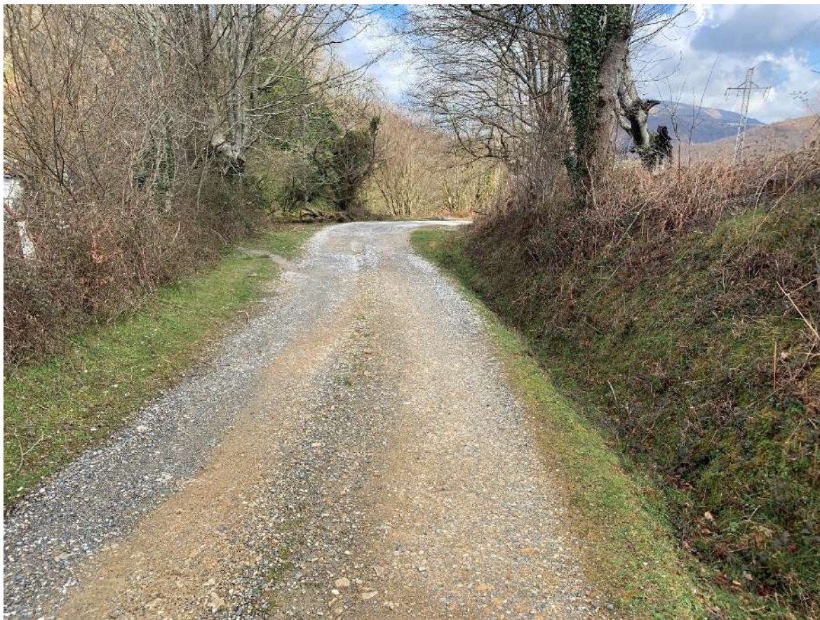
FOTOGRAFÍA 11: Vista general del camino. (Tramo 2)
