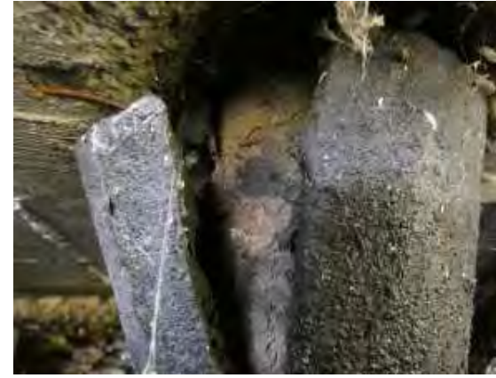
251104 Anclaje ( Estribo 2 izquierda)
