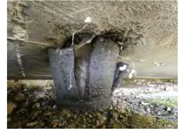
251104 Anclaje ( Estribo 2 izquierda)
