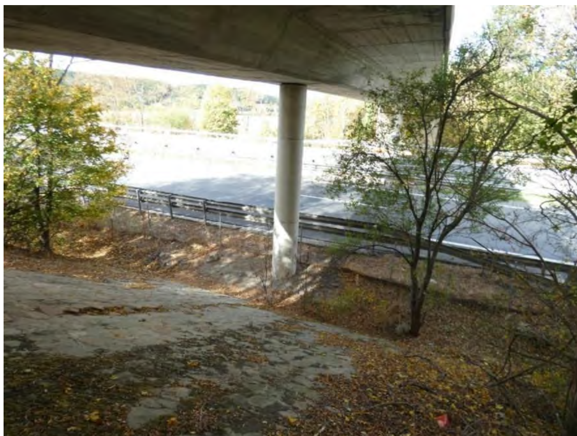
Figura 12. Vista de la pila 2 desde el estribo 2
