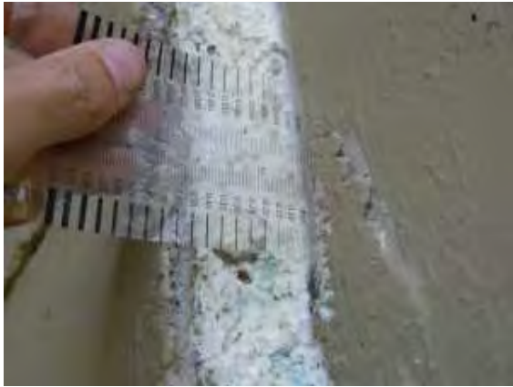
251104 Desplazamiento (Estribo 1)
