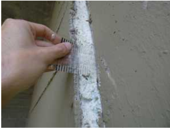
251104 Desplazamiento (Estribo 1)
