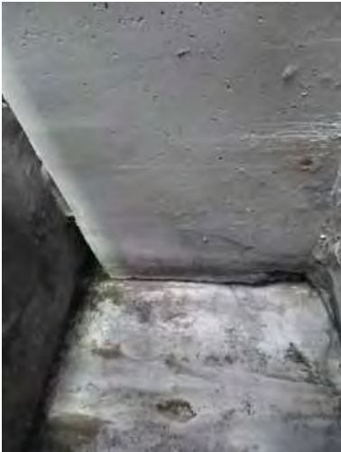
Foto 23 cabeza de viga estribo 2
