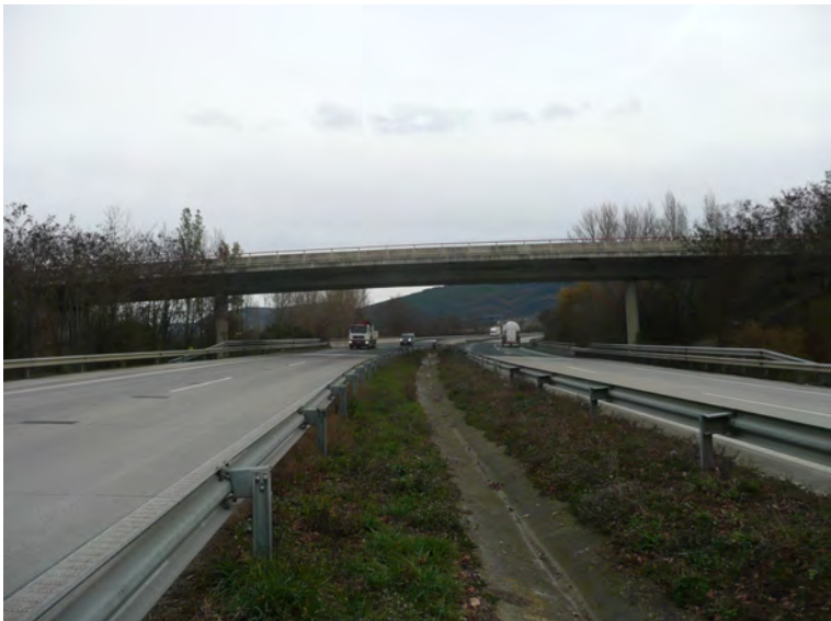
Vista inferior tablero.
