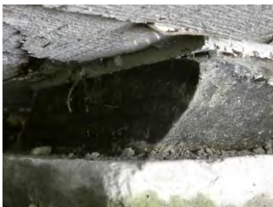
Figura 15. Apoyo con deformación excesiva (izquierda) y apoyo roto (derecha).
