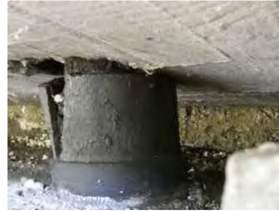
251104 Anclaje ( Estribo 2 derecha)
