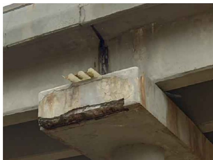
SITUACIÓN ACTUAL DE VIGAS Y DINTEL
