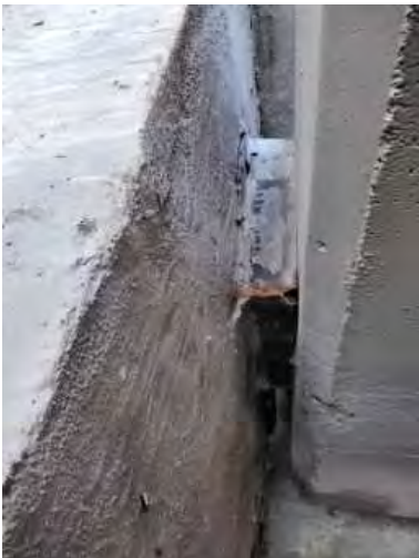
Foto 14 apoyo de viga de borde Estribo 1
