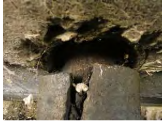
251104 Anclaje ( Estribo 2 derecha)
