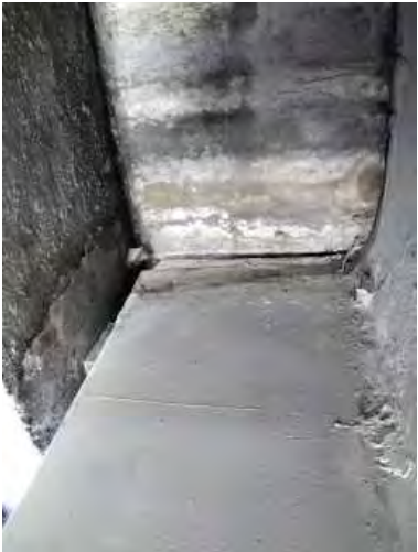
Foto 18 cabeza de viga estribo 1
