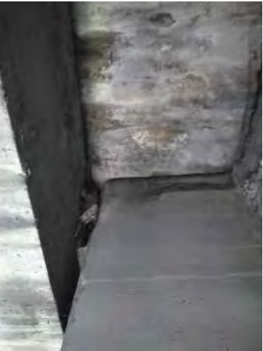
Foto 24 cabeza de viga estribo2
