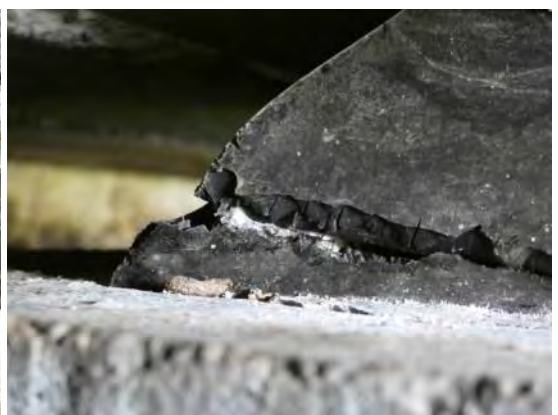
Figura 15. Apoyo con deformación excesiva (izquierda) y apoyo roto (derecha).
