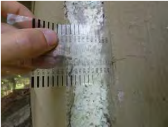
251104 Desplazamiento (Estribo 1)
