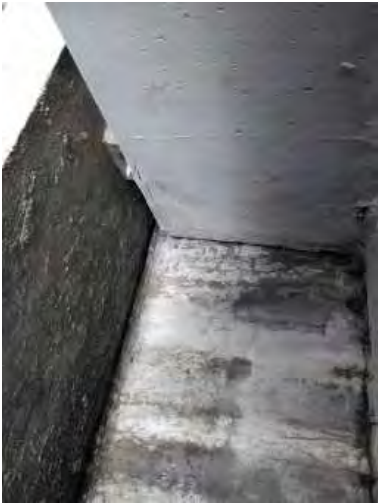
Fotos 19 cabeza de viga estribo 1
