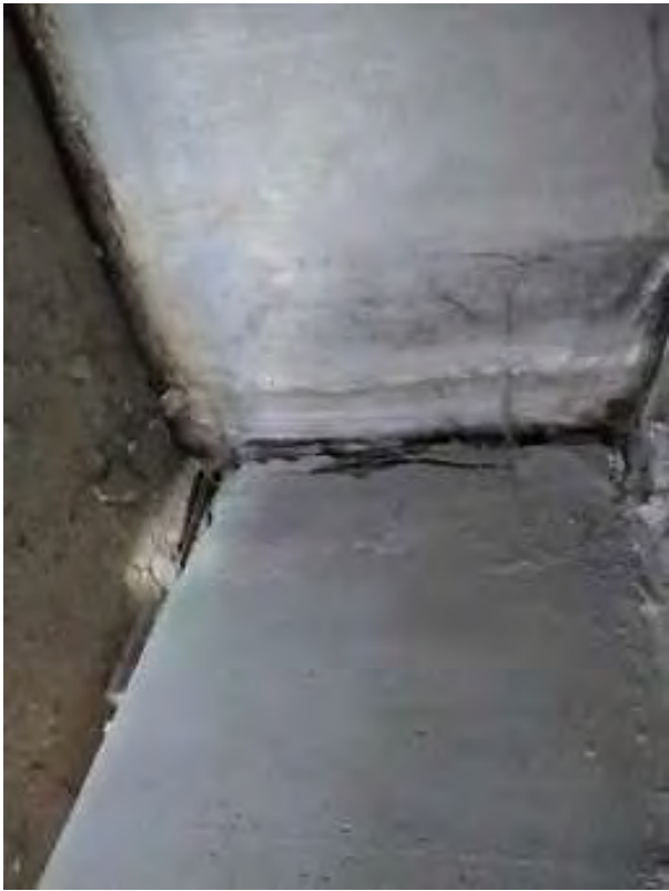
Foto 19 cabeza de viga sobre estribo1
