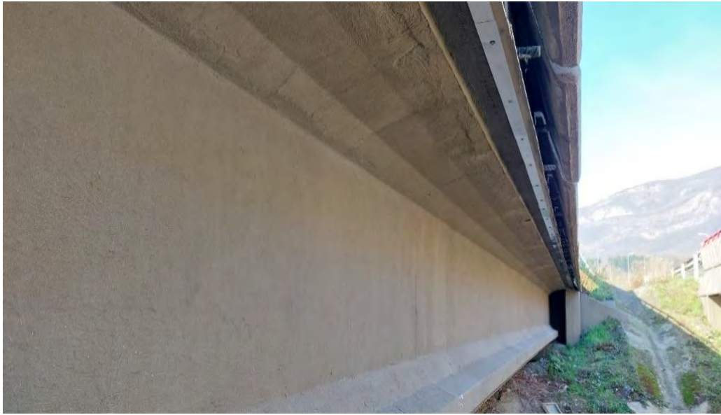
Viga de borde reparada y acabada con membrana cementosa y vierteaguas
