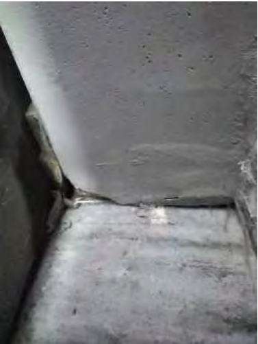
Foto 26 cabeza de viga estribo 2
