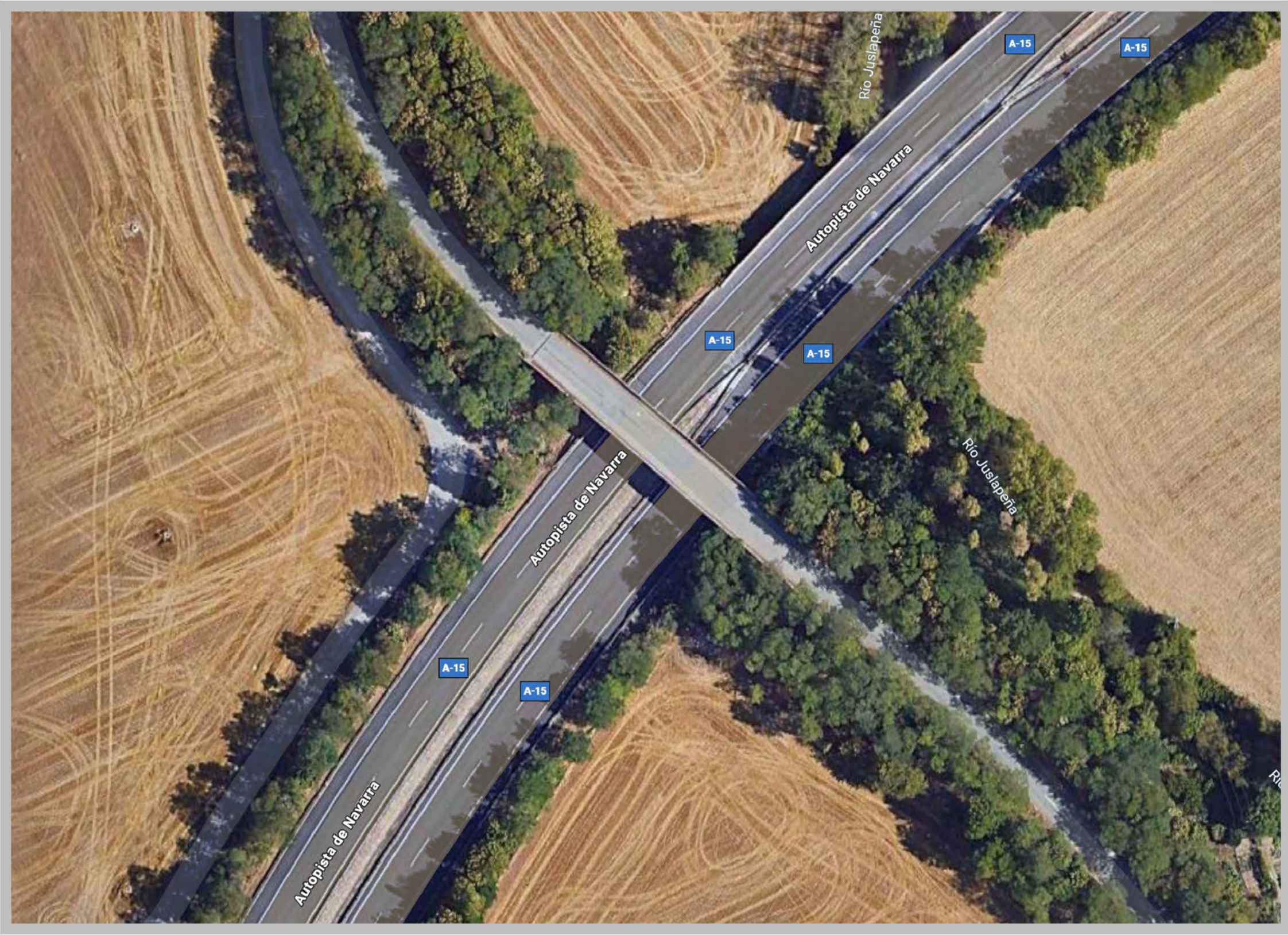
LOCALIZACIÓN DE LA ESTRUCTURA EN EL PK 93+600 DE LA AUTOVÍA A-15
