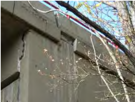
251104 Desplazamiento (Estribo 2)
