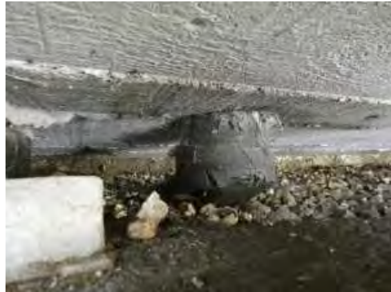
251104 Anclaje ( Estribo 1 derecha)
