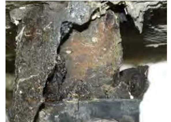
251104 Anclaje ( Estribo 1 izquierda)
