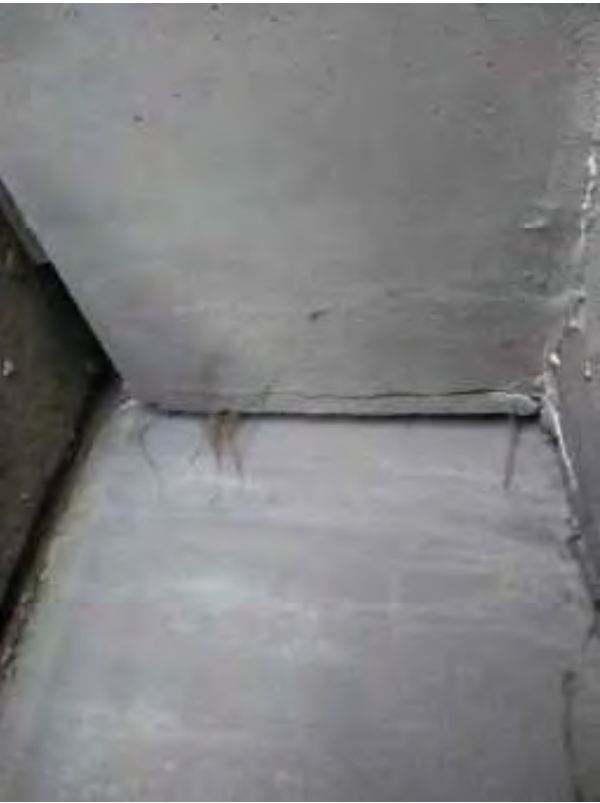
Foto 20 cabeza de viga sobre estribo1
