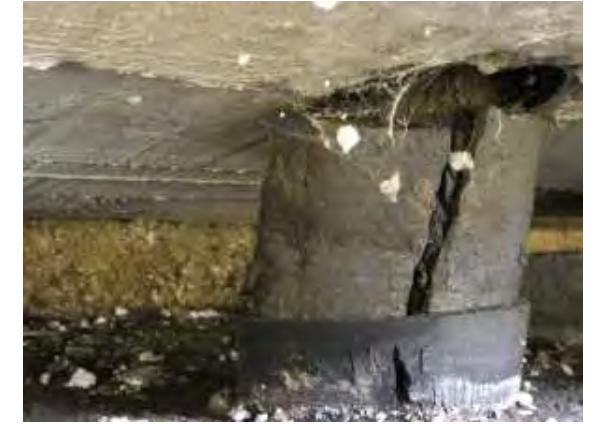
251104 Anclaje ( Estribo 2 derecha)
