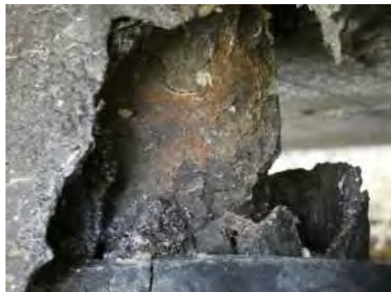
251104 Anclaje ( Estribo 1 izquierda)
