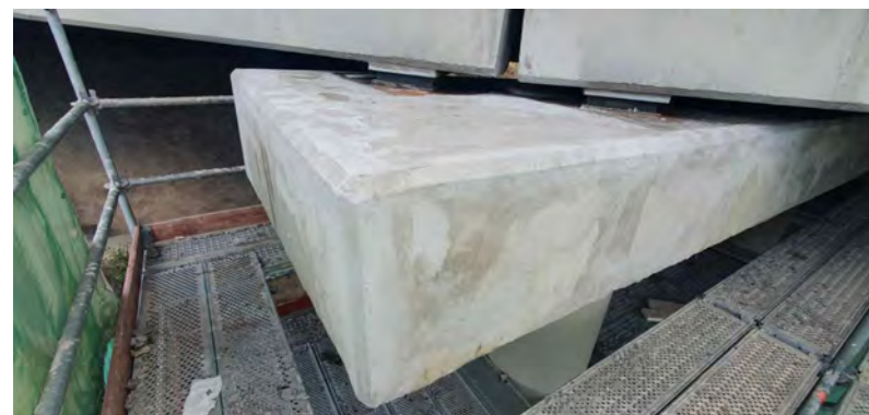
VIGAS Y DINTEL REPARADOS
