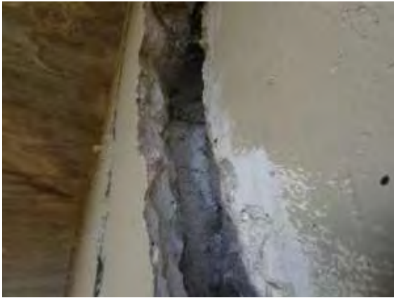
251104 Desplazamiento (Estribo 2)
