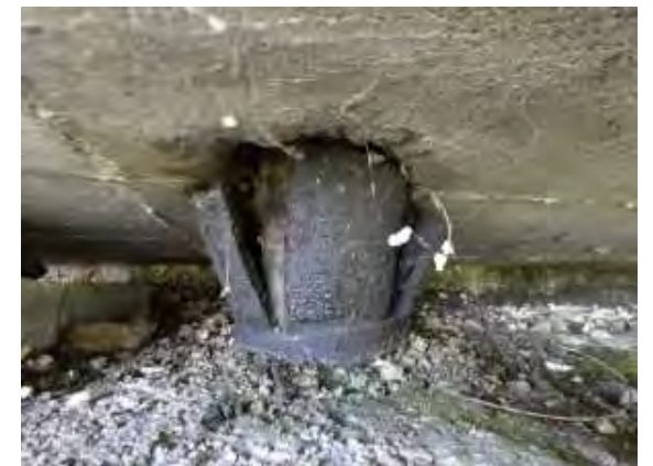
251104 Anclaje ( Estribo 2 izquierda)
