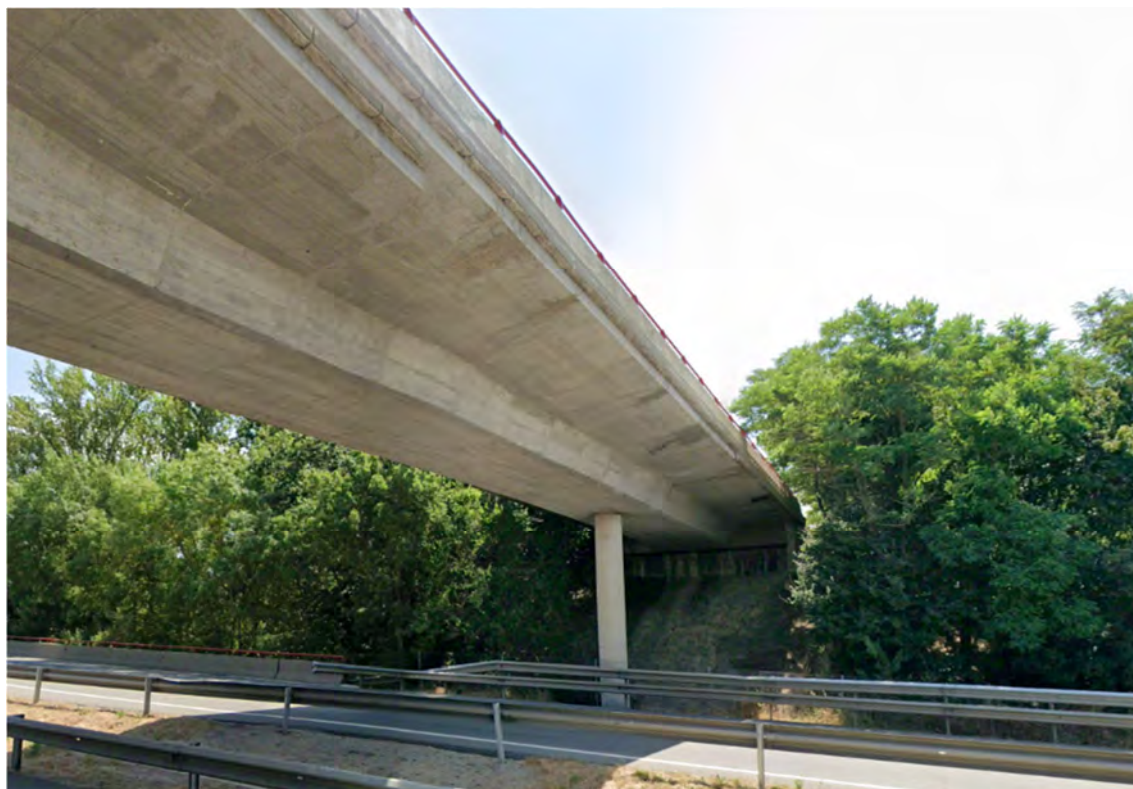
Figura 11. Vista del estribo 2 (con su talud revestido) y de la pila monofuste 2
