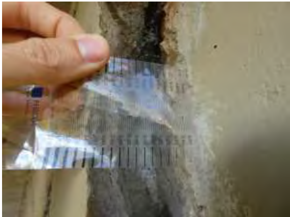
251104 Desplazamiento (Estribo 2)
