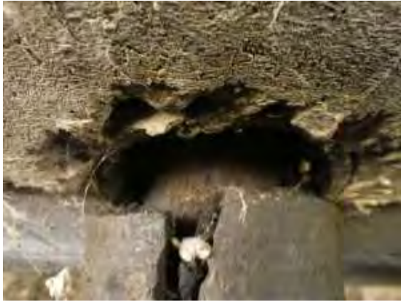
251104 Anclaje ( Estribo 2 derecha)
