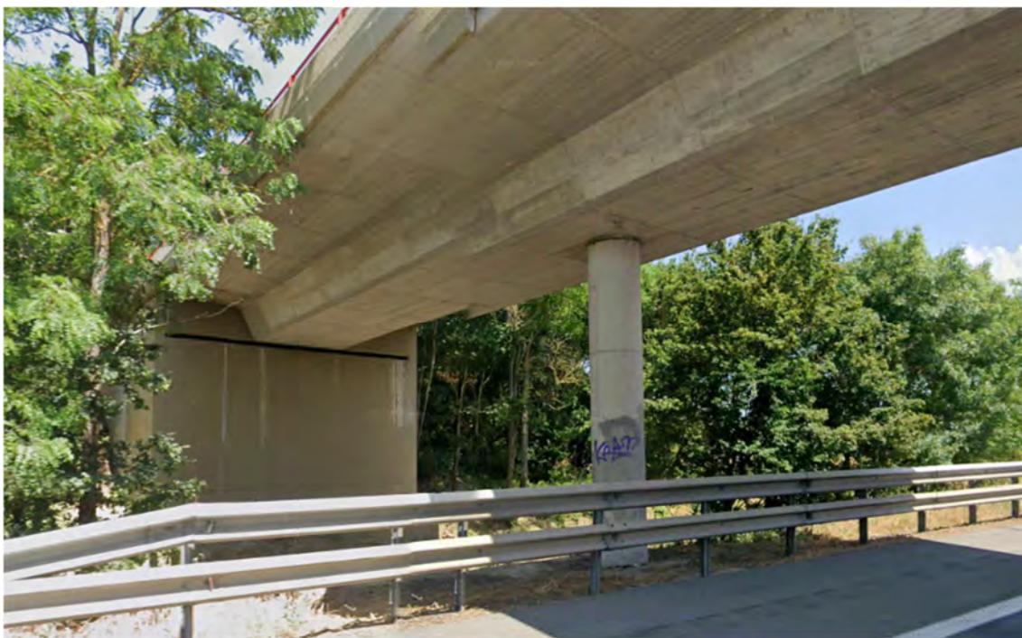
Figura 10. Vista del estribo 1 y de la pila monofuste 1
