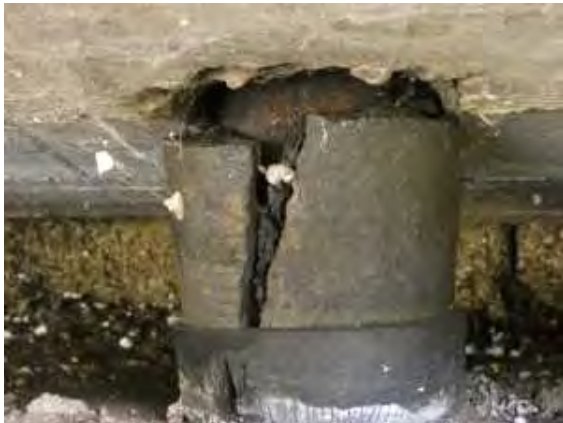
251104 Anclaje ( Estribo 2 derecha)
