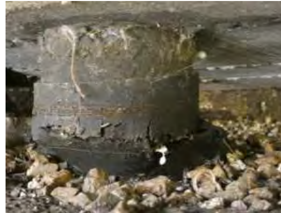
251104 Anclaje ( Estribo 1 derecha)
