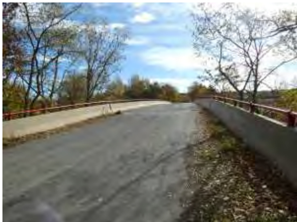
251104 Asiento en la losa de transición
