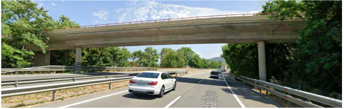
Figura 3. Foto (desde calzada PK+) del paso superior situado en P.K. 93+600 de la AP-15
