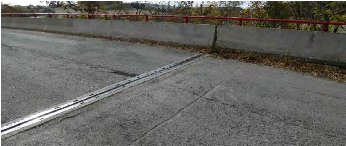
Figura 9. Juntas de dilatación ubicadas en los extremos del puente
