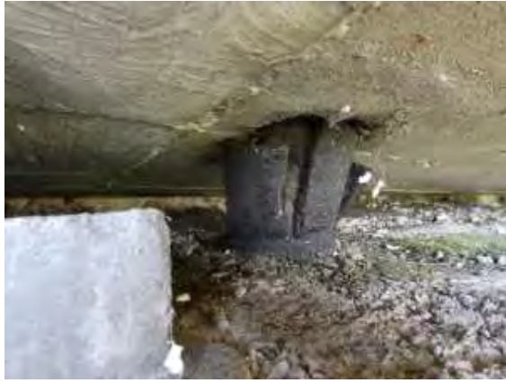
251104 Anclaje ( Estribo 2 izquierda)
