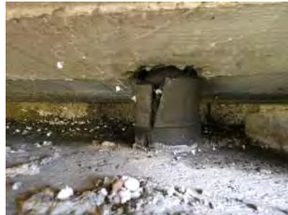
251104 Anclaje ( Estribo 2 derecha)
