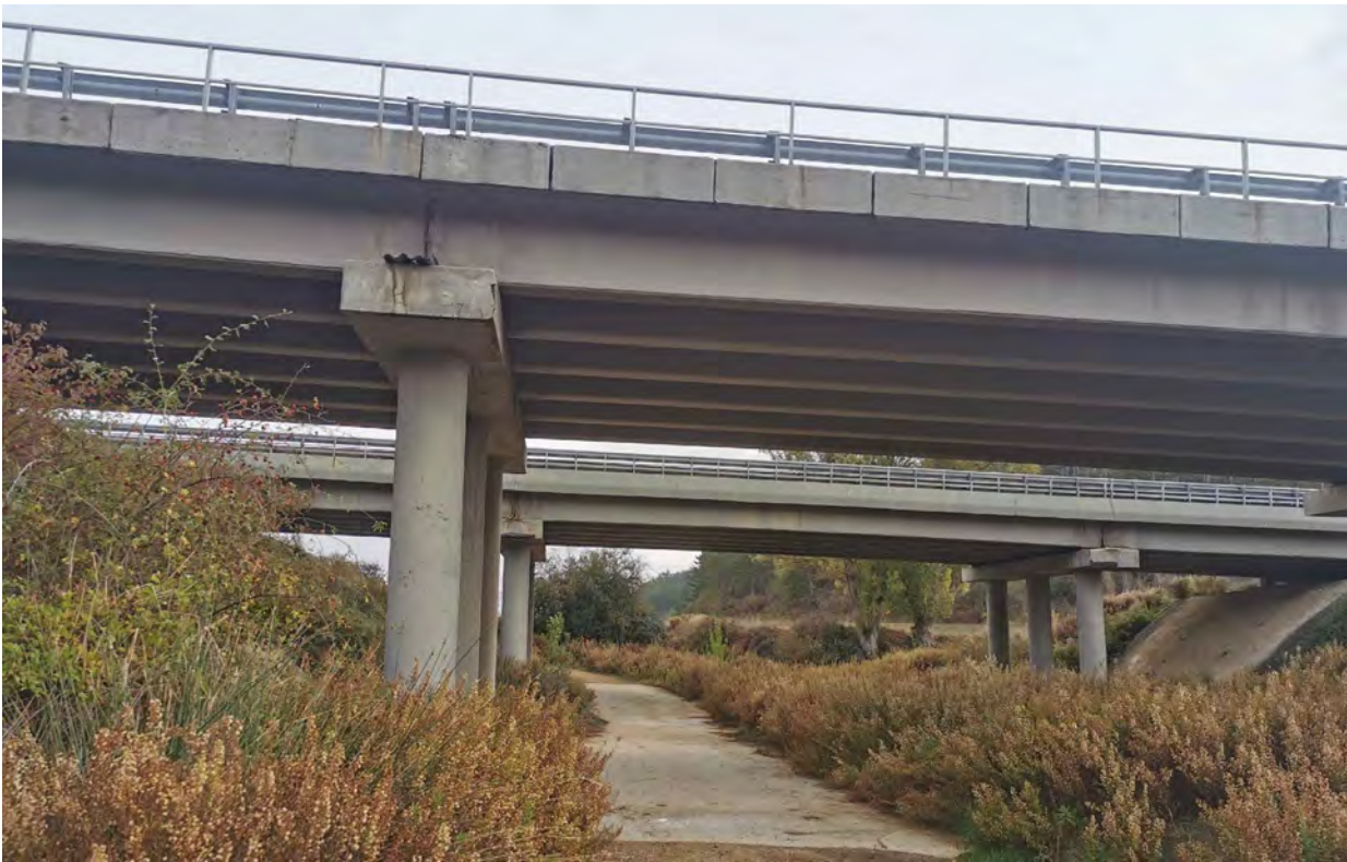
VISTA DESDE LA PARTE INFERIOR DEL VIADUCTO (ALTURA REDUCIDA Y SIN TRÁFICO)
