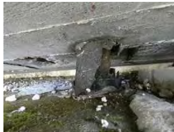
251104 Anclaje ( Estribo 1 izquierda)
