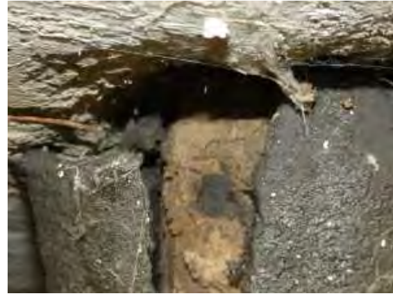
251104 Anclaje ( Estribo 2 izquierda)
