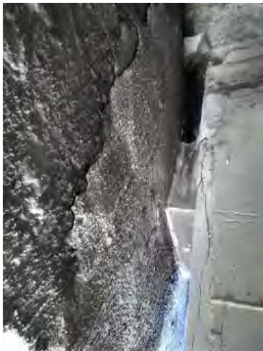
Foto 17 apoyo viga de borde Estribo 2
