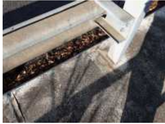
zona anclaje bionda
