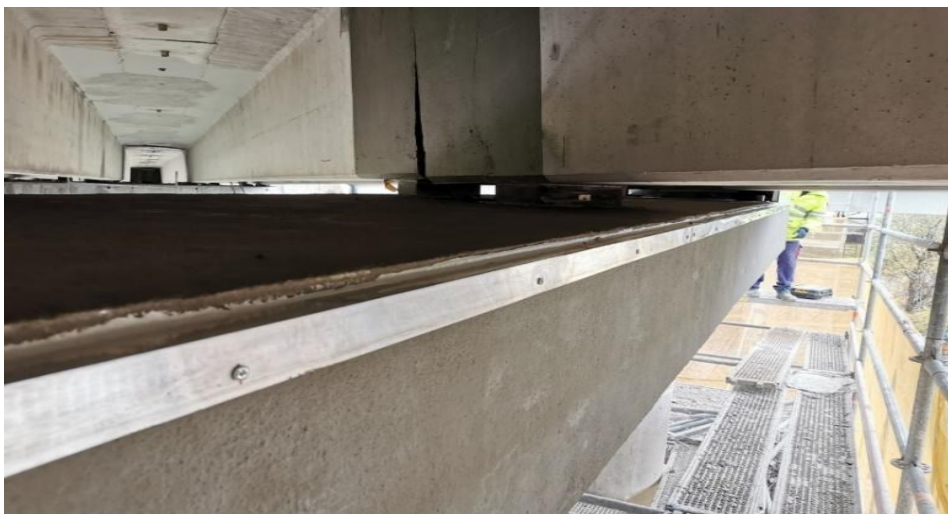
Cargadero y cabezas de viga terminadas con un tratamiento de membrana cementosa y vierteaguas
