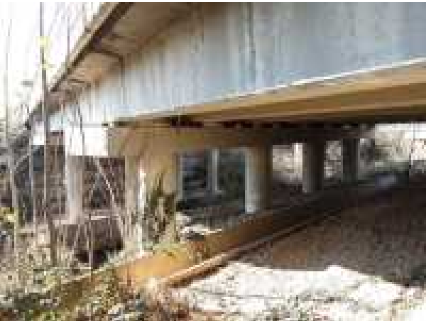
apoyos p2 buen estado
