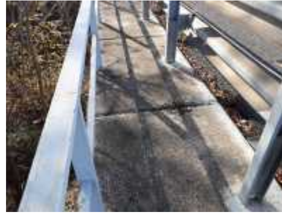
desprendimiento recubrimiento
