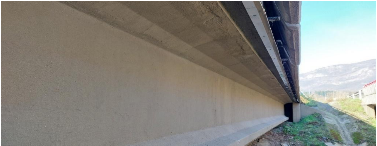
Viga de borde reparada y acabada con membrana cementosa y vierteaguas
