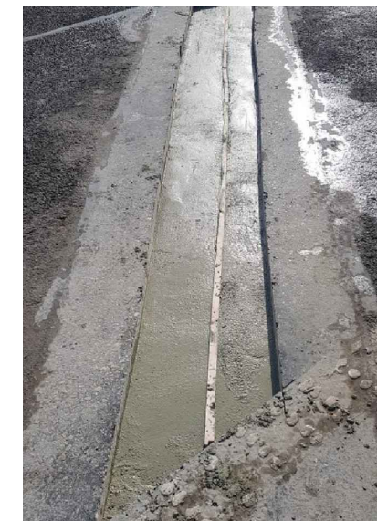
RECONSTRUCCIÓN DE ESTRUCTURAL LABIOS JUNTAS (SUPERIOR)
