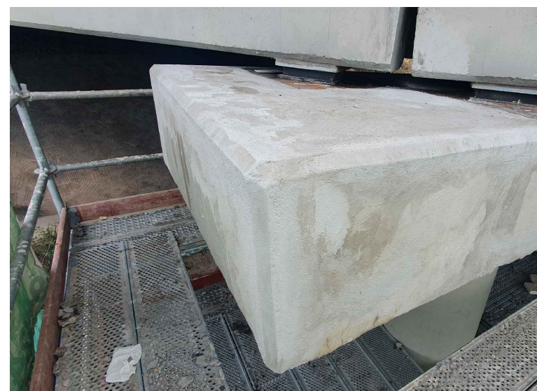
VIGAS Y DINTTEL REPARADOS
