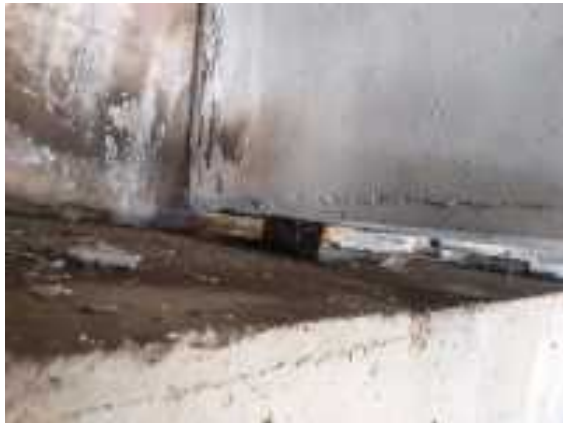
viga 2 sobre e2
