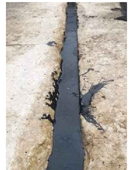
RECONSTRUCCIÓN DE ESTRUCTURAL LABIOS JUNTAS (SUPERIOR)
