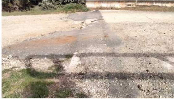
Foto 11 Junta sobre estribo2
