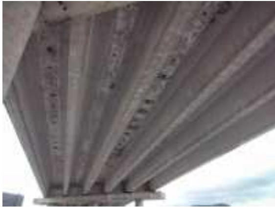
Foto 32 Losa vano calzada norte
