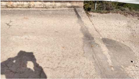
Foto 7 Junta sobre estribo 1
