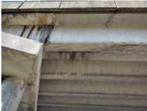
Foto 16 viga de borde vano calzada norte
