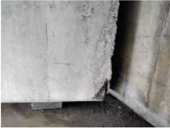
Foto 40 cabeza de viga sobre estribo2 2
