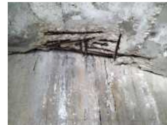
Foto 16 losa sobre estribo 1
