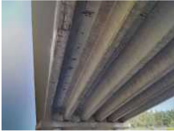
Foto 28 viga de borde
