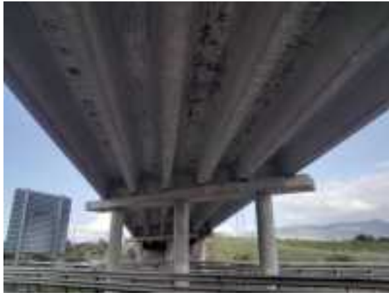
Foto 24 pila en mediana
