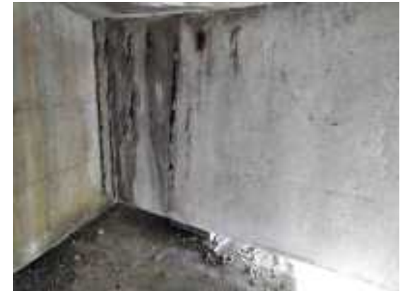
Foto 39 cabeza de viga sobre estribo 2
