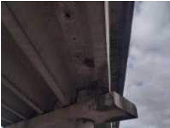
foto 41 viga de borde vano cerca de estribo 1
