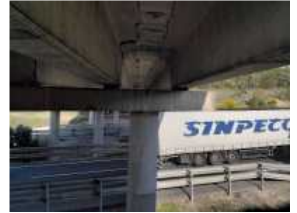
Foto 23 pila de norte
