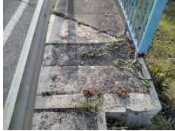
Fotos 7 reparar final de acera para evitar aguas en estribo 2
