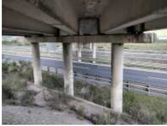
Foto 23 Pila sentido norte
