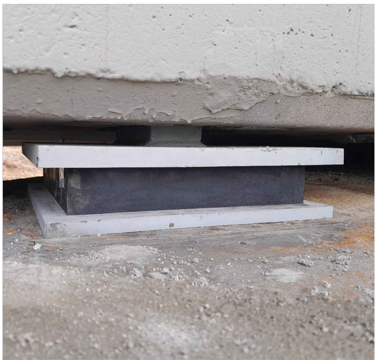
APOYO CON TETÓN METÁLICO (VIGAS DE BORDE)
