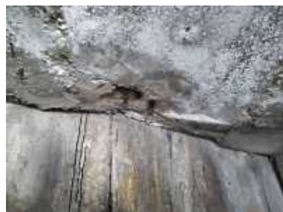
Foto 20 losas sobre estribo 1
