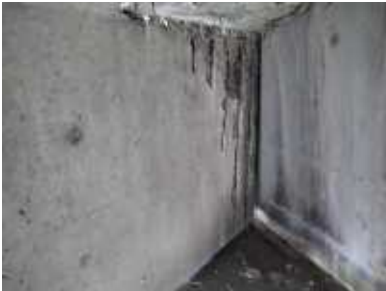
Foto 46 cabeza de viga sobre estribo2
