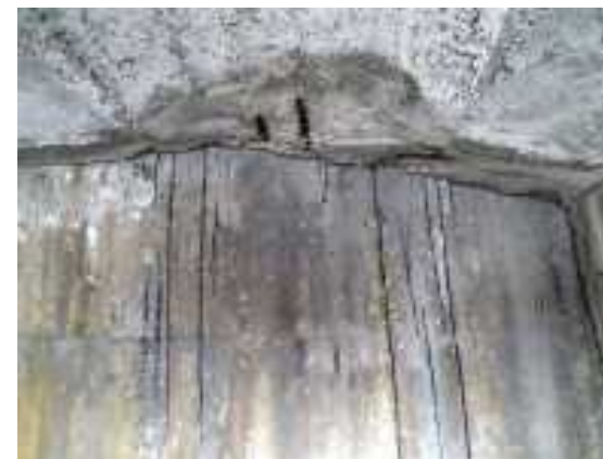
Foto 19 Losa sobre estribo1
