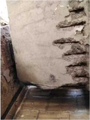
Foto 19 cabeza de viga sobre estribo sur
