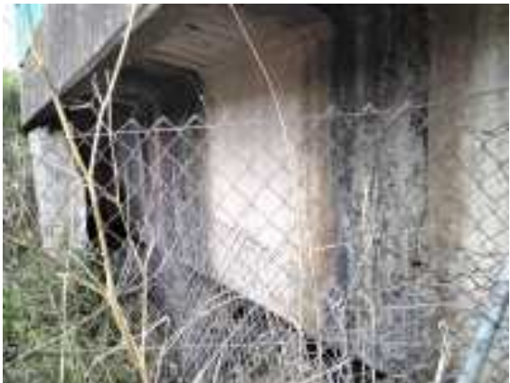
Foto 42 viga de borde cerca de estribo 1
