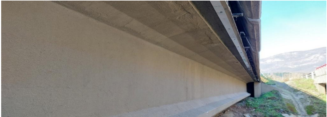
Viga de borde reparada y acabada con membrana cementosa y vierteaguas
