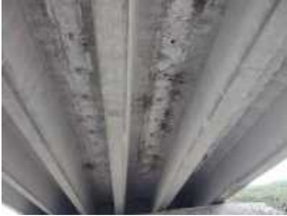
Foto 30 losa vano estribo 2
