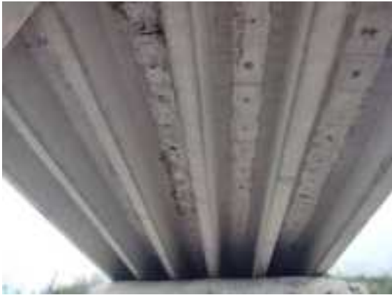
Foto 33 losa vano estribo1
