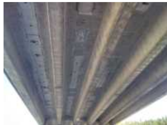
Foto 24 losa vano calzada norte
