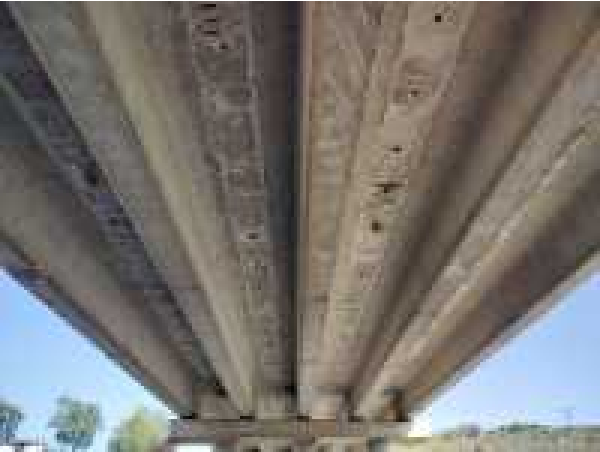
Foto 14 vano sobre calzada norte
