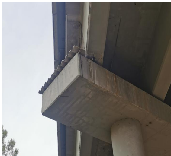
Aspecto de cargadero y cabezas de viga protegidas con membrana cementosa y superficie de cargadero protegido con faldón de chapa inoxidable
