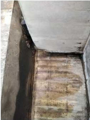
Foto 18 cabeza de vigas sobre estribos sur
