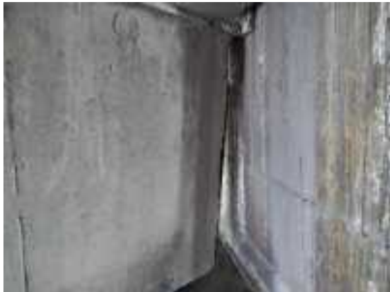
Foto 49 cabeza de viga sobre estribo 2
