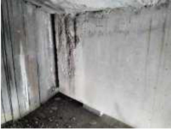
Foto 18 cabeza de viga sobre estribo 1
