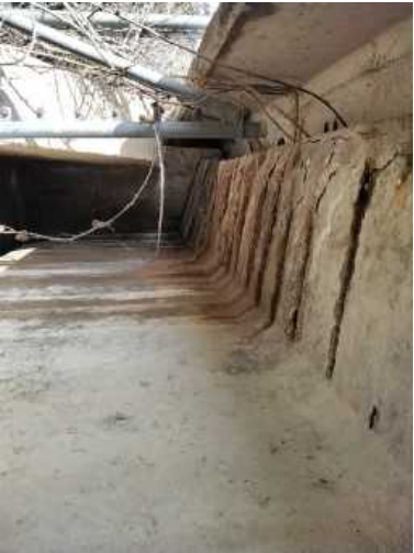
Foto 21 ala de viga de borde sobre estribo sur
