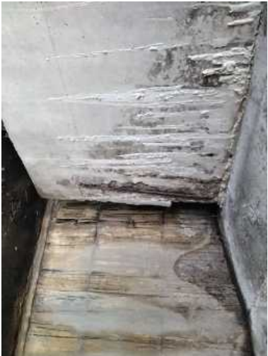
Foto 17 cabeza de viga sobre estribos sur
