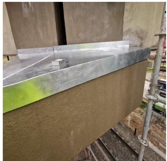
Aspecto de cargadero y cabezas de viga protegidas con membrana cementosa y superficie de cargadero protegido con faldón de chapa inoxidable
