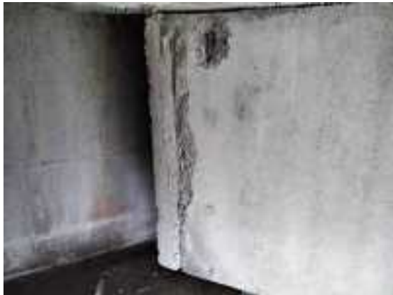
Foto 45 cabeza de viga sobre estribo 2
