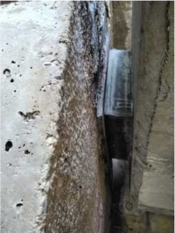
Foto 34 apoyo de viga de borde sobre estribo norte
