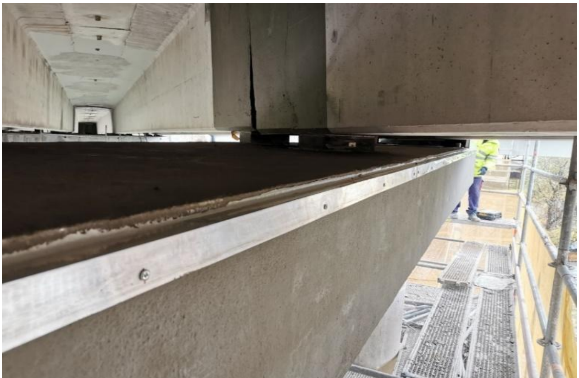
Cargadero y cabezas de viga terminadas con un tratamiento de membrana cementosa y vierteaguas
