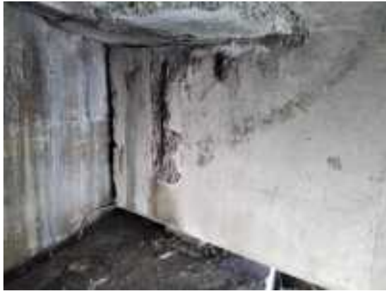
Foto 21 cabeza de viga sobre estribo 1
