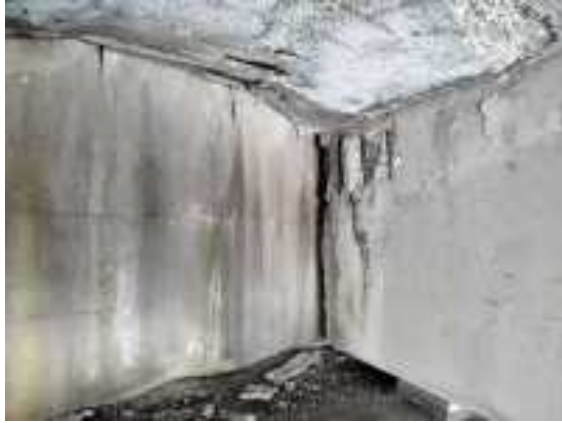
Foto 14 cabeza de viga sobre estribo 1
