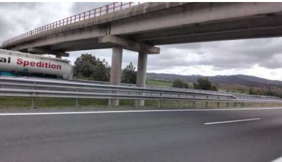
Foto 26 Viga de borde más al norte
