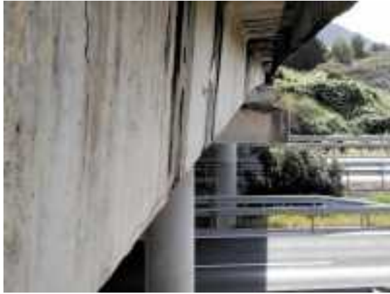
Foto 36 pila calzada sur
