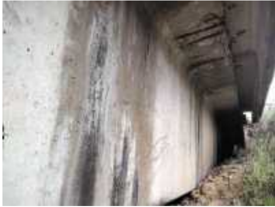
Foto 43 viga de borde estribo 2
