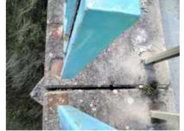
Fotos 9 sellar acera para evitar entrada de aguas a dintel
