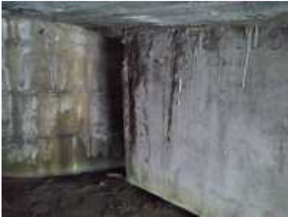
Foto 37 cabeza de viga sobre estribo 1
