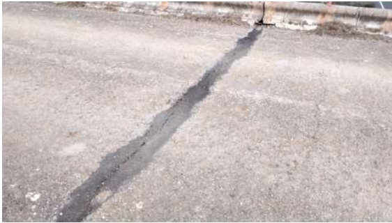
Foto 9 Junta sobre pila 2
