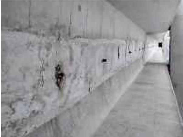
Foto 11 losa vano cerca de estribo 1
