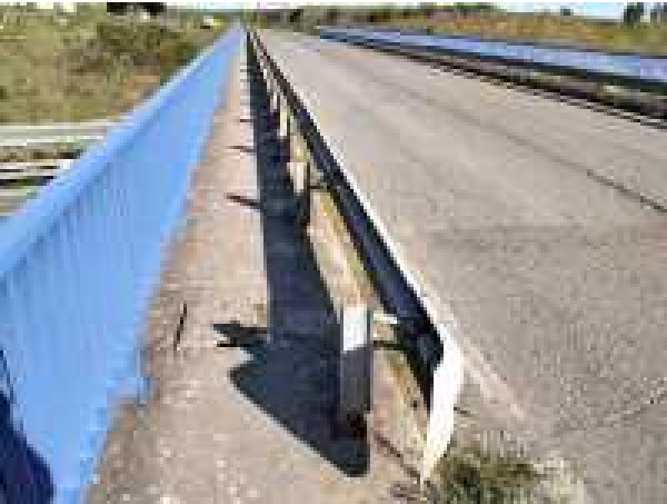
Foto 2 barandillas ambos márgenes reparadas y pintadas
