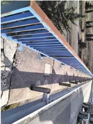
Foto 4 barandilla margen izquierdo
