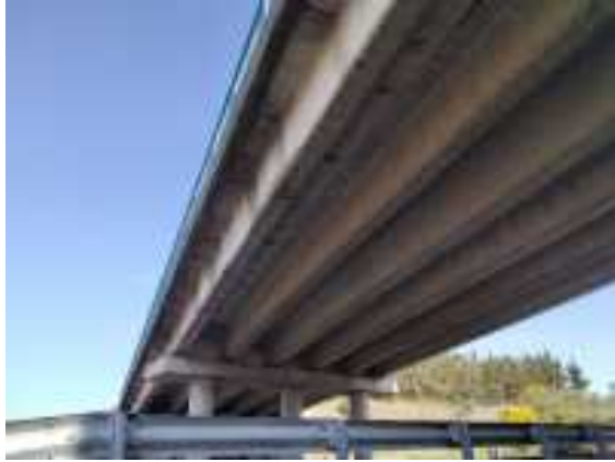
Foto 27 vigas de borde
