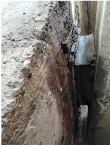
Foto 15 apoyo de viga de borde en estribo sur
