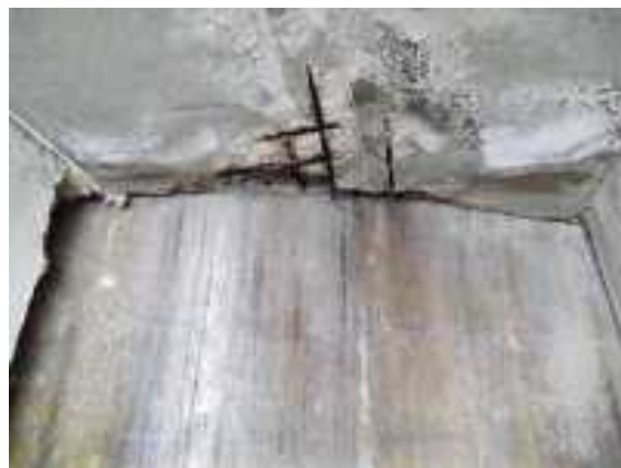
Foto 38 losa sobre estribo 2
