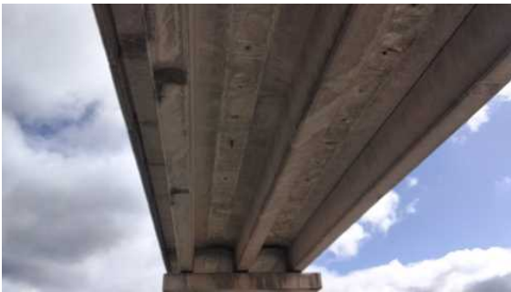
Foto 23 Losa vano sobre calzada sur
