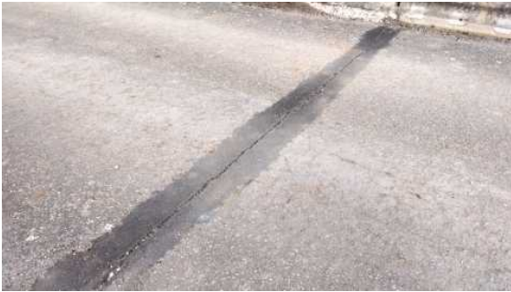
Foto 8 Junta sobre pila 1
