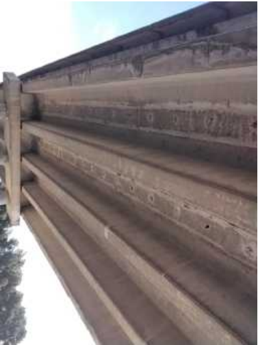
Foto 25 Losa sobre calzada sur
