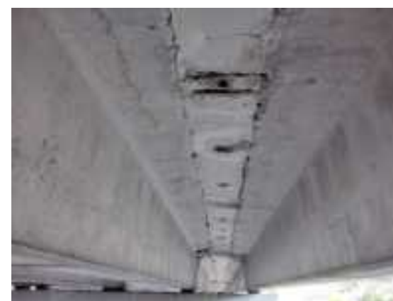
Foto 22 losa vano cerca de estribo 1
