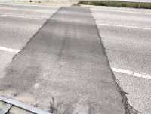
Foto 8 Junta sobre Estribo 1.
