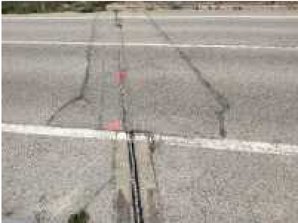
Foto 9 Junta sobre estribo 2.
