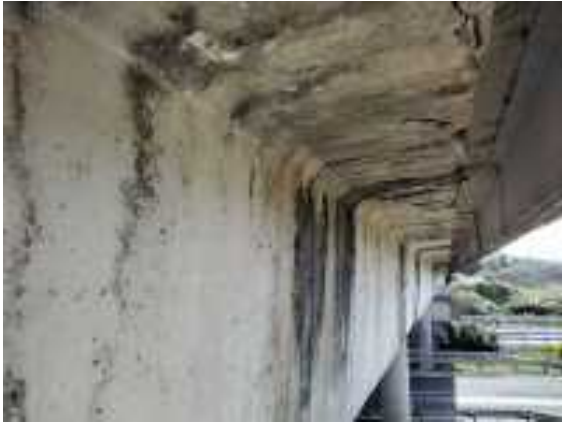
Foto 32 viga de borde
