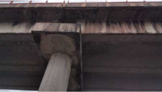
Foto 30 cabezas de vigas sobre pila 2
