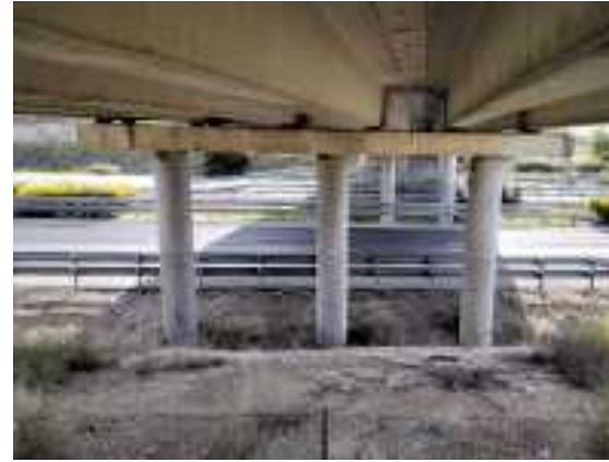
Foto 35 pila en calzada sur
