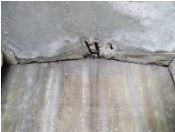
Foto 34 losa sobre estribo 2
