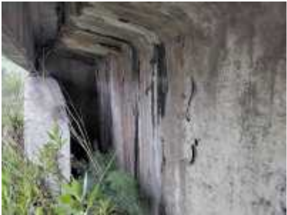
Fotos 50 cabeza de viga sobre estribo2
