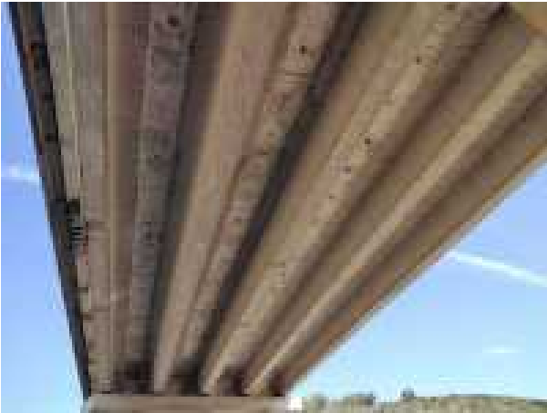
Foto 18 vano sobre calzada sur
