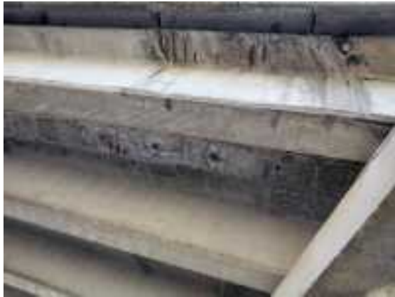
Foto 15 viga de borde en vano de calzada norte
