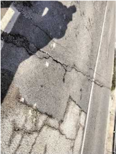
Foto 8 Junta sobre estribo sur
