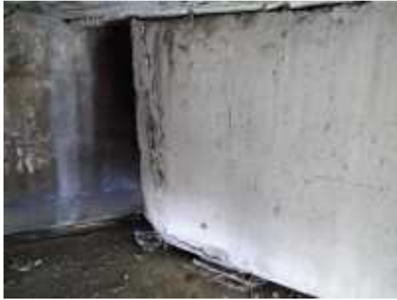
Foto 44 cabeza de viga sobre estribo2
