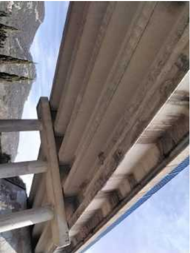
Foto 27 viga de borde sobre calzada norte
