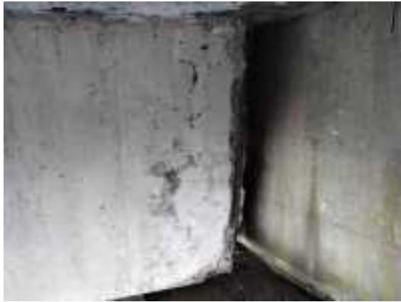
Foto 15 cabeza de viga sobre estribo 1
