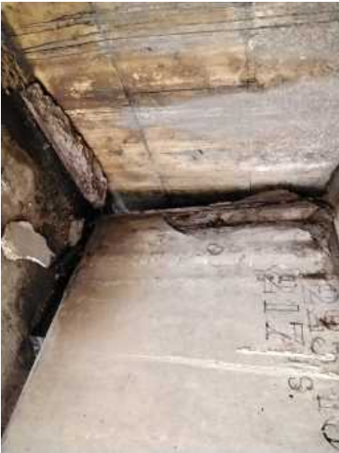
Foto 20 cabeza de viga sobre estribo sur
