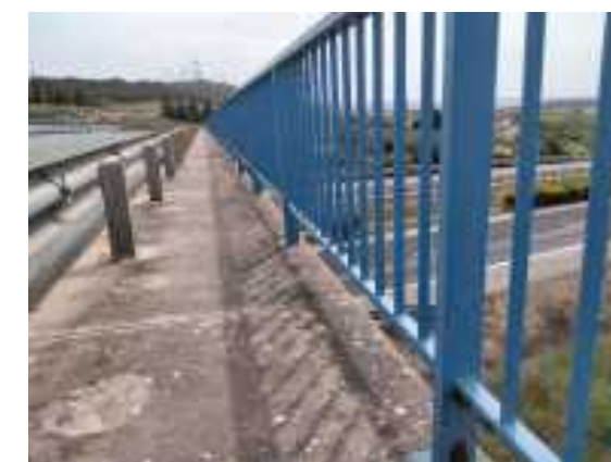
Foto 5 Reparar barandillas y pintar.
