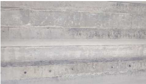
Foto 24 vano sobre calzada norte
