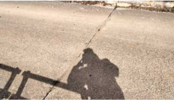
Foto 10 Junta sobre pila 3
