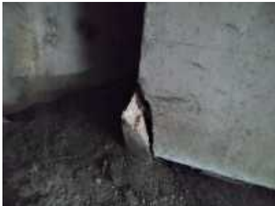
Foto 39 cabeza de viga sobre estribo 1
