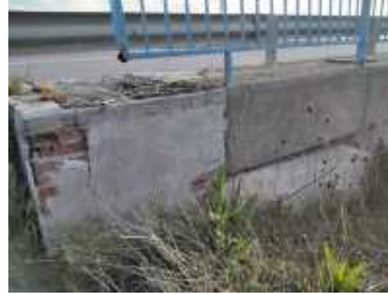
Foto 8 reparar final de acera para evitar aguas en estribo 2
