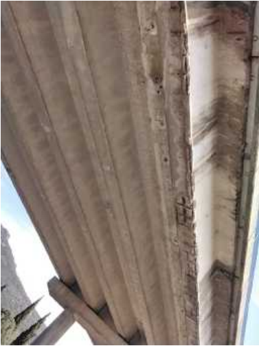
Foto 23 viga de borde sobre calzada sur
