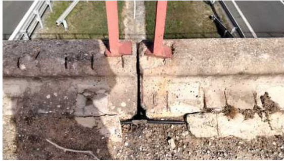
Foto 3 Conducciones 3n junta sobre pila 2
