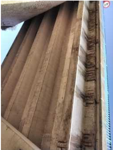
Foto 22 viga de borde
