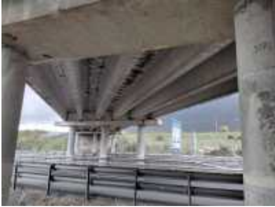
Foto 31 losa vano calzada sur
