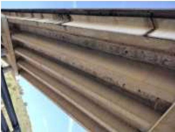
Foto 19 viga de borde sobre calzada sur
