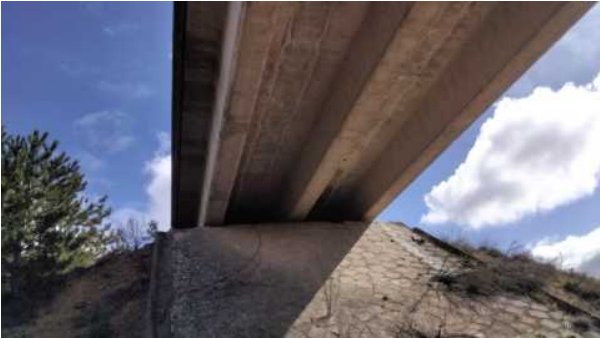
Foto 22 Losa vano estribo1
