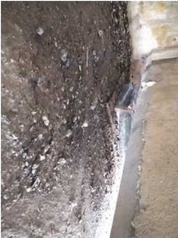
Foto 36 apoyo de viga de borde de estribo norte de
