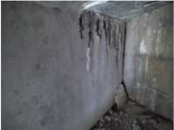
Foto 38 cabeza de viga sobre estribo 1
