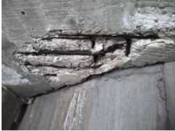
Foto 48 losa sobre estribo 2
