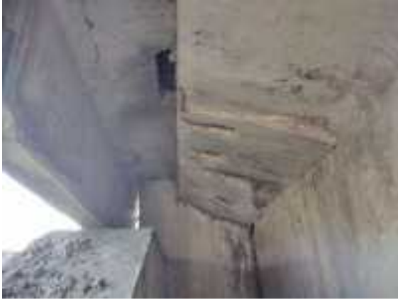
Foto 13 ala de viga sobre estribo 1
