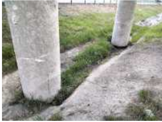
Foto 28 limpiar cuneta de hormigón bajo pila de mediana y arreglar cuneta
