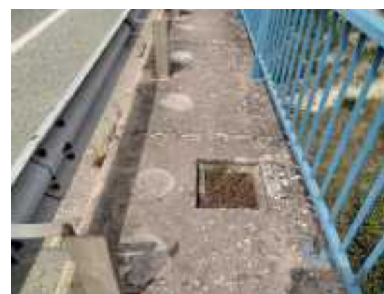
Foto 2 Reparar arqueta en acera.
