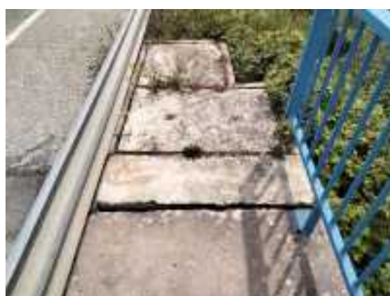
Foto 10 Reparar unión de acera con arqueta.
