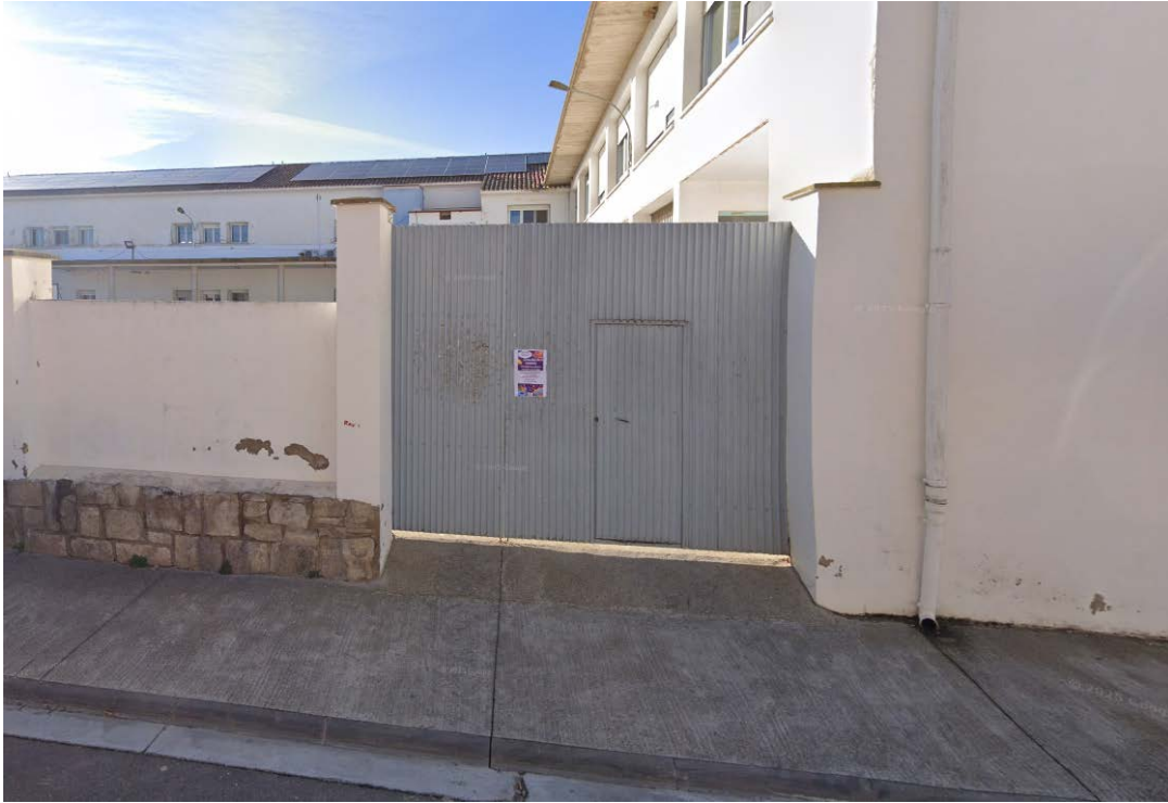
Acceso desde calle San Francisco Javier.
