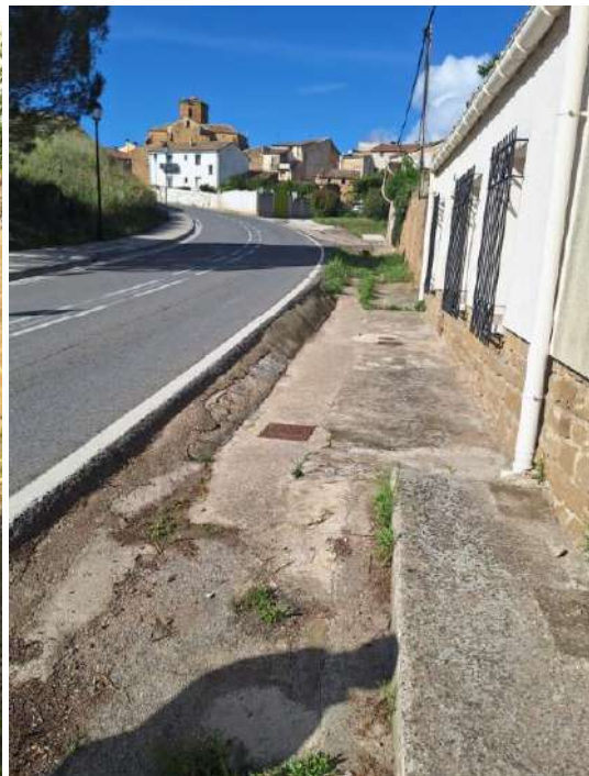
Salto y diferencias de cotas en el pavimento actual
