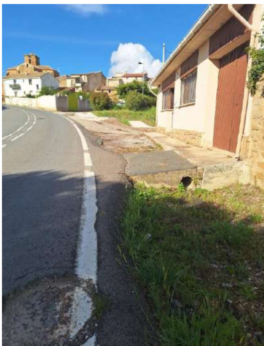
Salto y diferencias de cotas en el pavimento actual
