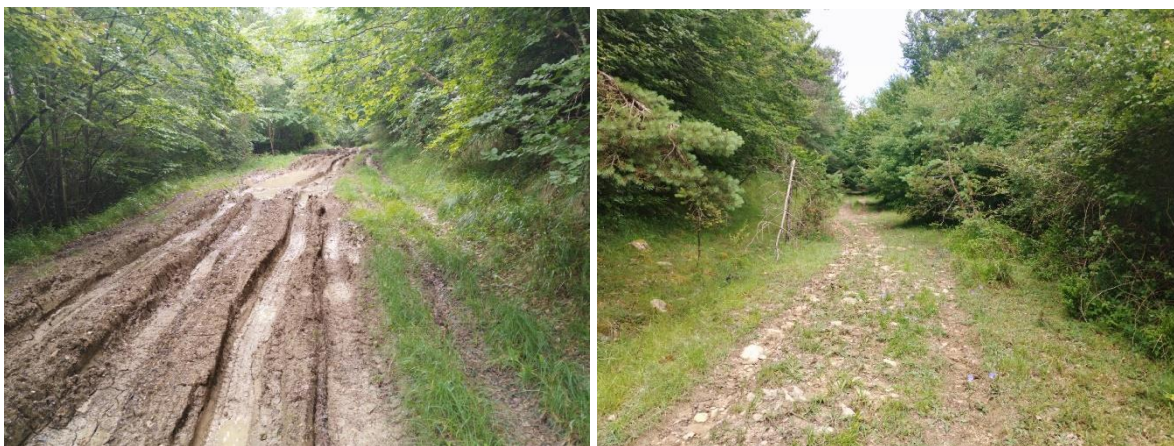
Instantáneas que evidencian el estado actual de dos tramos del camino a acondicionar
