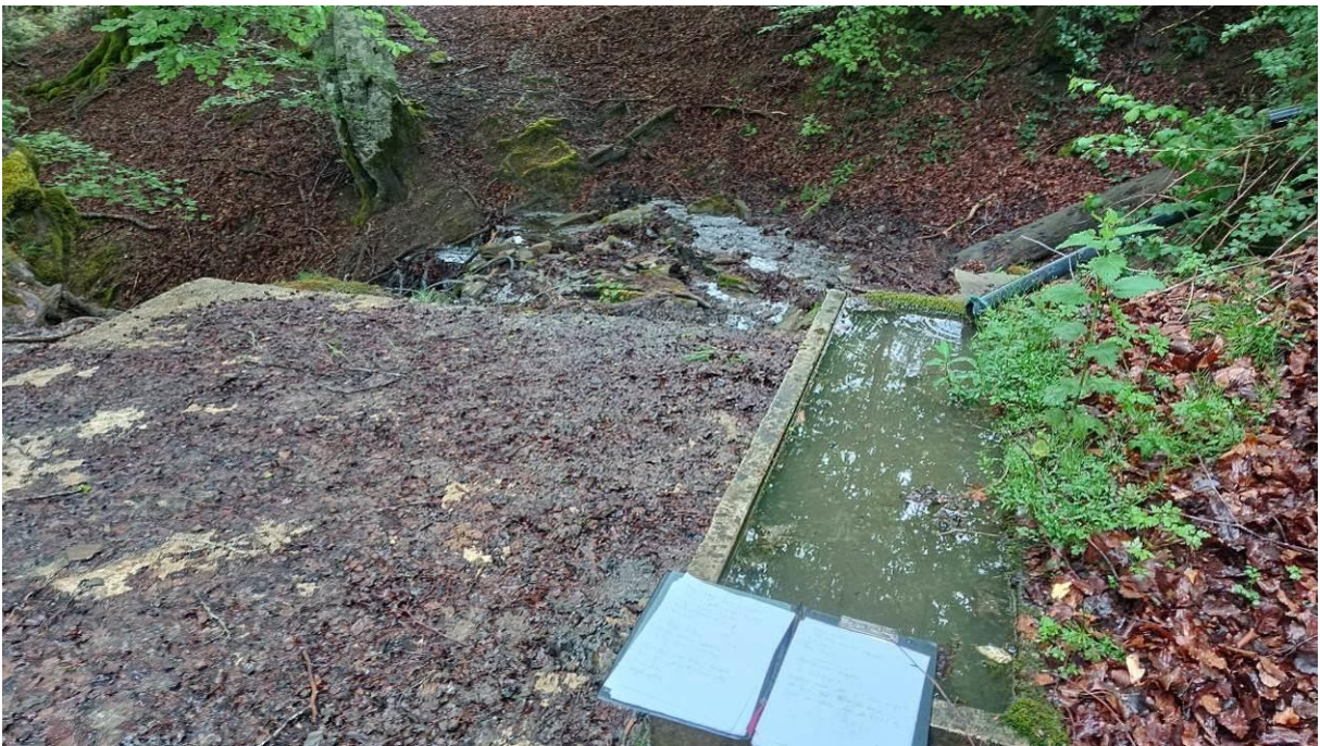
Foto 4: Abrevaderos actual de Zidratea, a incrementar con otros y nueva captación
