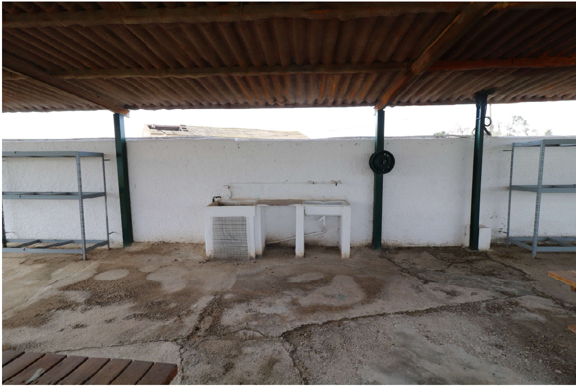
Foto 11: Vista general zona fregaderos.
