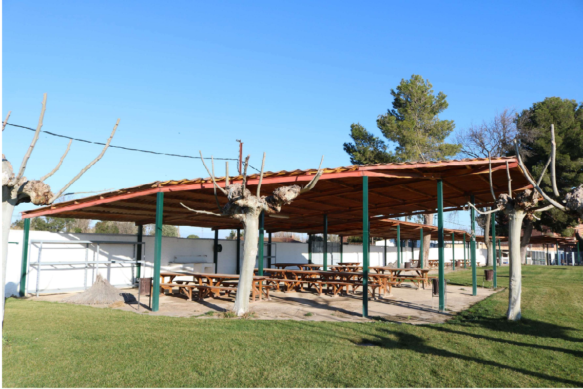
Foto 3: Vista general zona merenderos.
