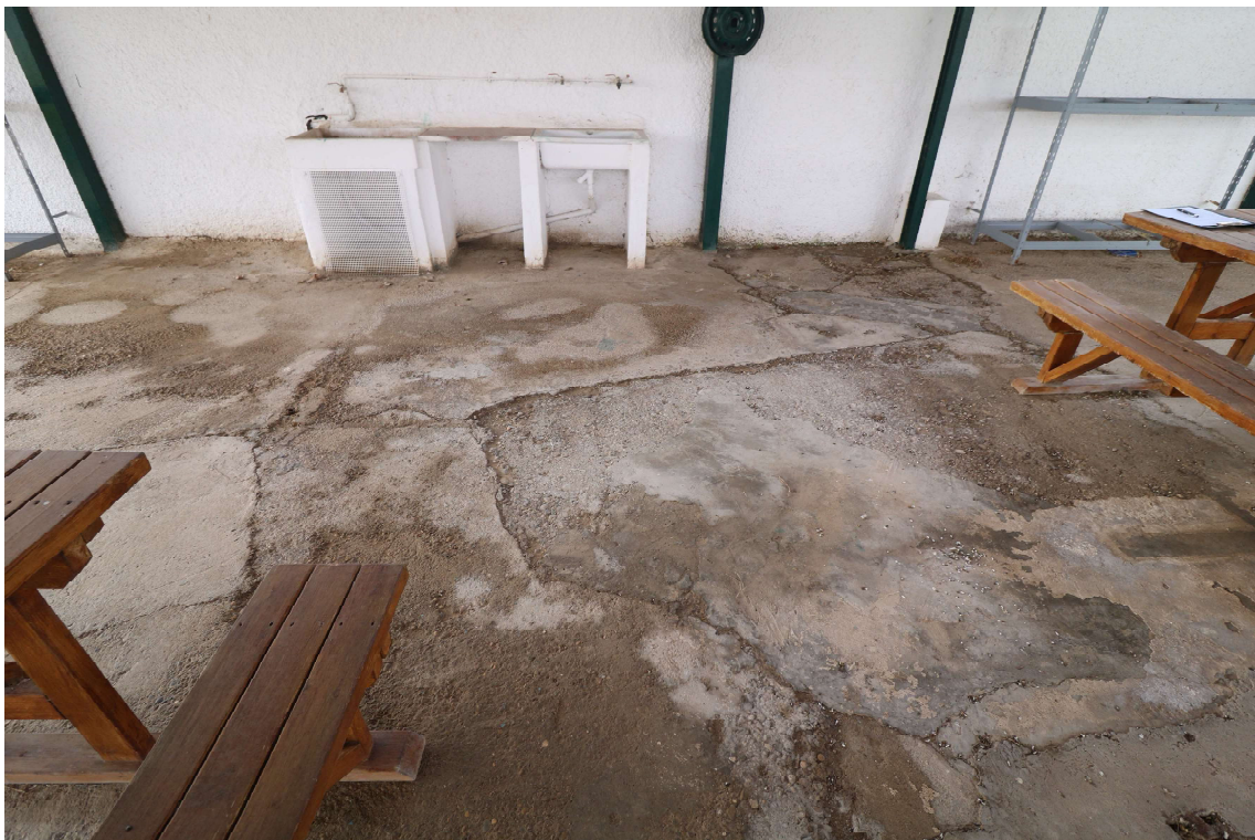
Foto 12: Vista detallada zona fregaderos.
