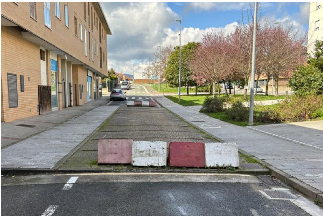
Figura 2. Fotografía de las barreras instaladas en la Calle Eutzandia.
