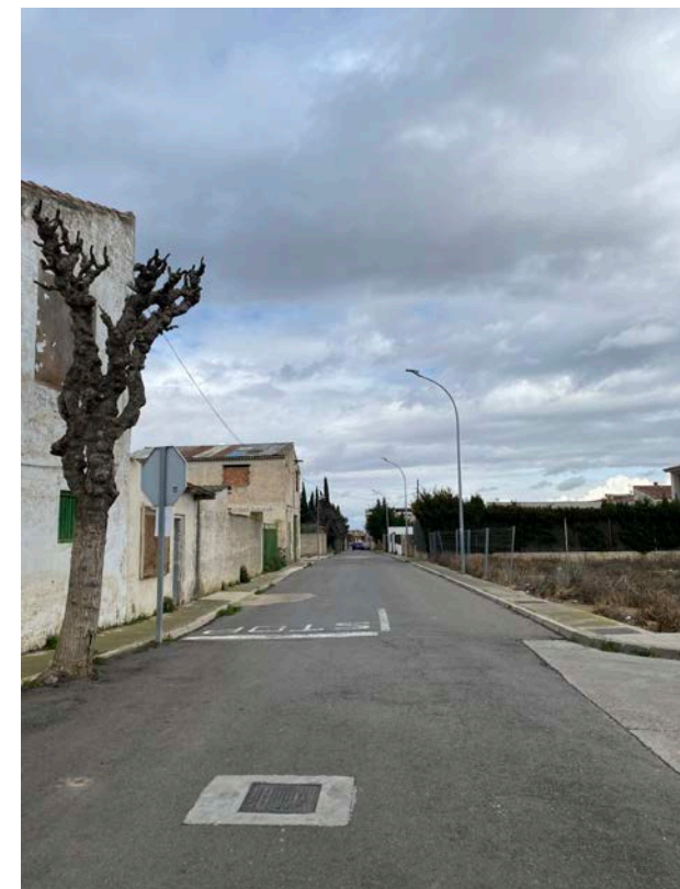
Vista general de la calle Ágreda desde entronque calle Corea (final)
