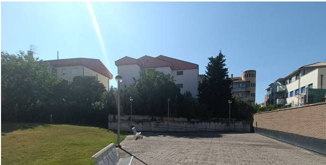
VISTA DESDE LA URBANIZACIÓN INTERIOR. FACHADA ESTE
