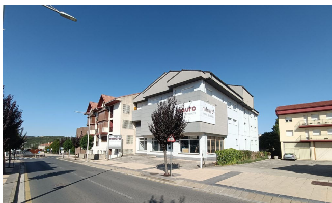
VISTA DESDE LA ZONA SUROESTE. FACHADAS SUR Y OESTE
