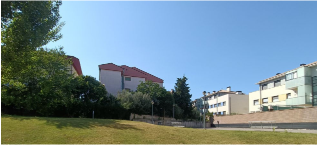
VISTA DESDE LA URBANIZACIÓN INTERIOR. FACHADA ESTE
