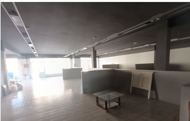
VISTA ACTUAL DE LA PLANTA BAJA
