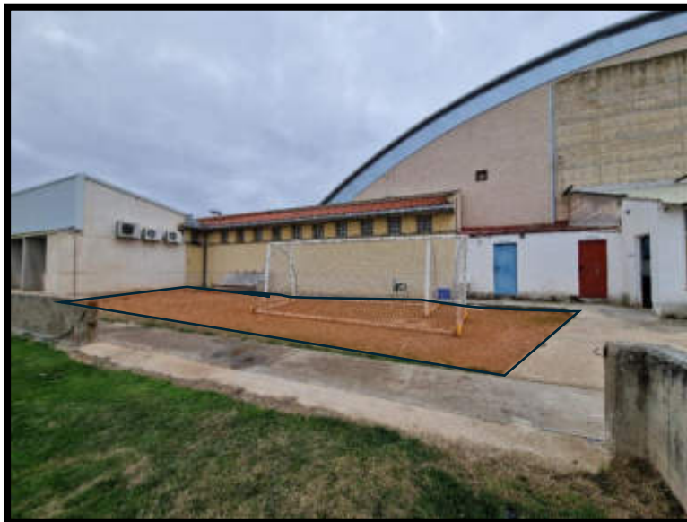
Ubicación de la ampliación
