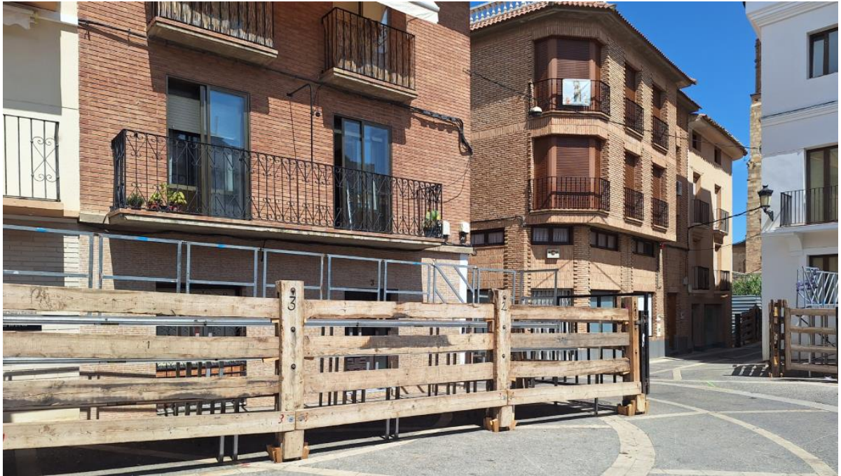
Vista lateral de plaza. Encuentro Avenida Tudela y Calle Iglesia
