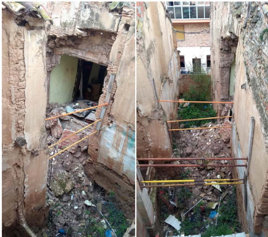
Apuntalamiento lateral de los edificios Lechuga 35 con Adoberia 18 y lechuga 31
