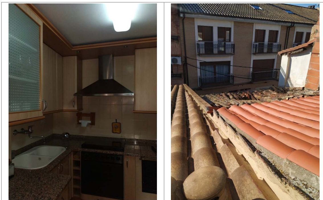
Estado de la parte del edificio de Lechuha 29 que se encuentra arreglado y reformado. Se corresponde con la zona del edificio que se accede desde la propiedad de Lechuga 27 y parte de la cubierta.
