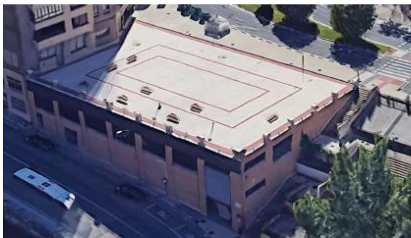
Ilustración 1: Edificio de NASERTIC en Calle Orcoyen
