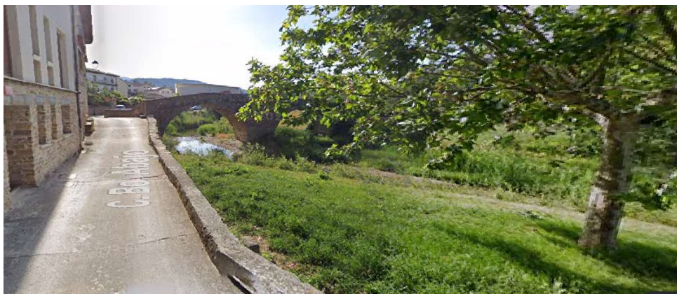
Vista del puente medieval desde el emplazamiento de la Zona de reposo planteada
