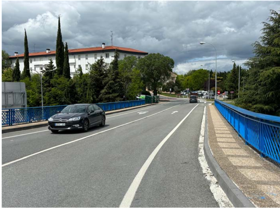
Figura 6 Estado actual - Puente sobre la A-12
