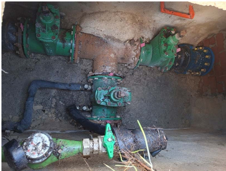
Figura 14 Interior de la arqueta en el PK0+305
