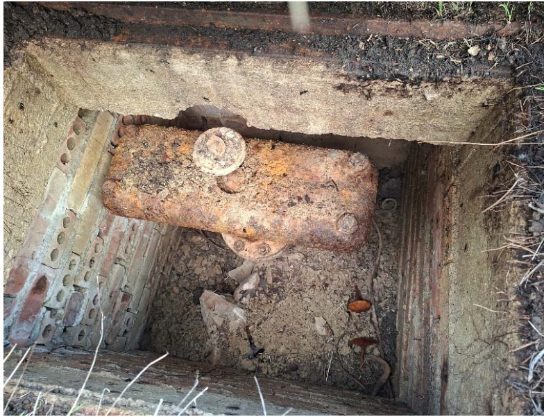
Figura 15 Interior de la arqueta en el PK0+338
