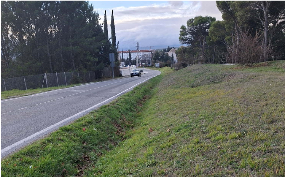
Figura 4 Estado actual - Carretera NA-6053
