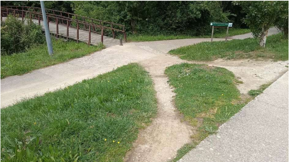
Foto 4: Tramo 6c, enlace con el Paseo del Arga
