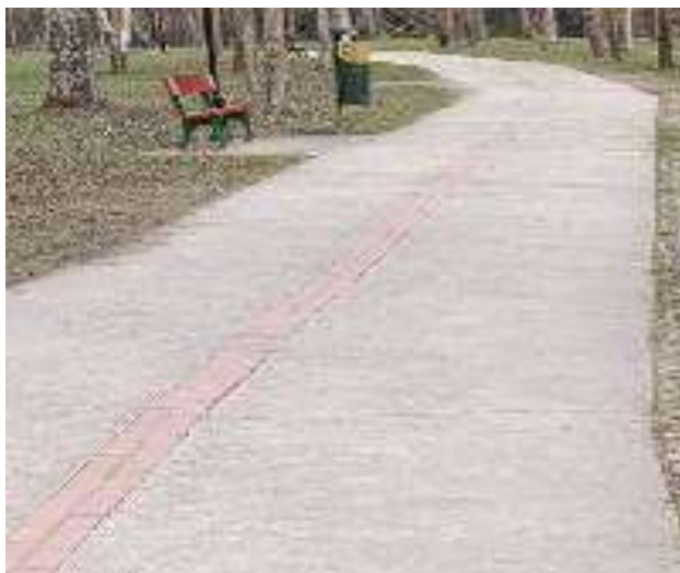
Imagen de ampliación de caminos de hormigón con solape de bordillo jardinero plano
