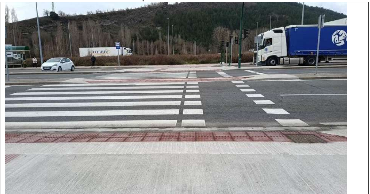
Foto 3: Tramo 5 paso de cebra con grupo semafórico
