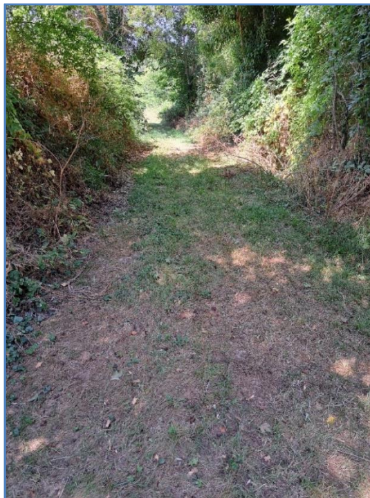
Imagen 12. Camino ramal 3 entre PR 3.1 y PC 1.07
