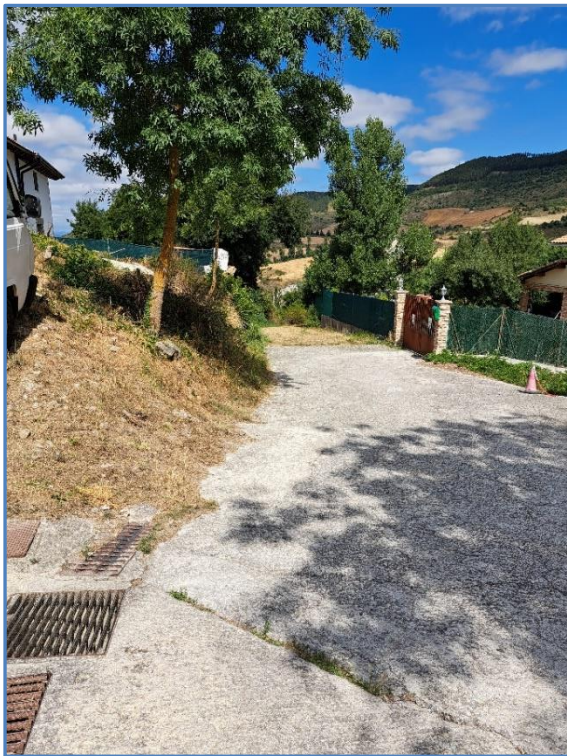
Imagen 5. Zona emisario entre PC 1.16 y PC 1.15
