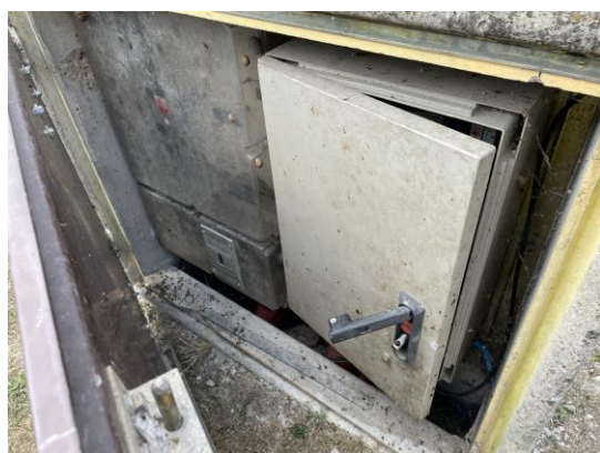
Instalación de interruptores
