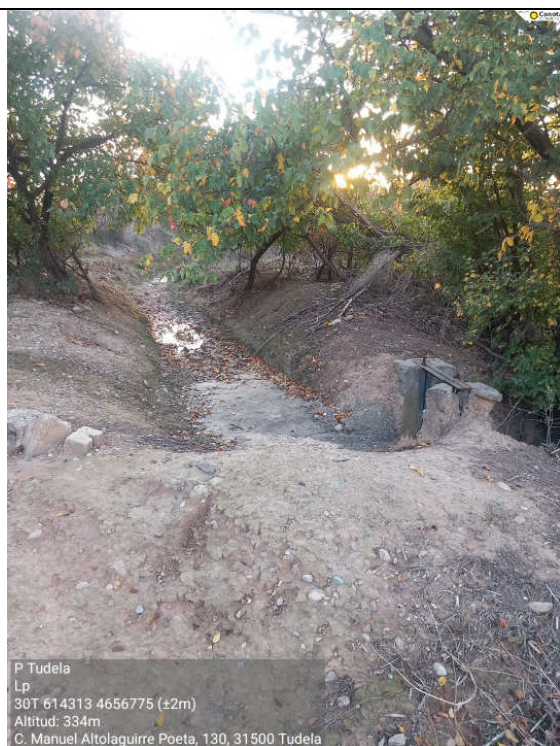
Foto 2. Acequia Santa Quiteria, continuidad
