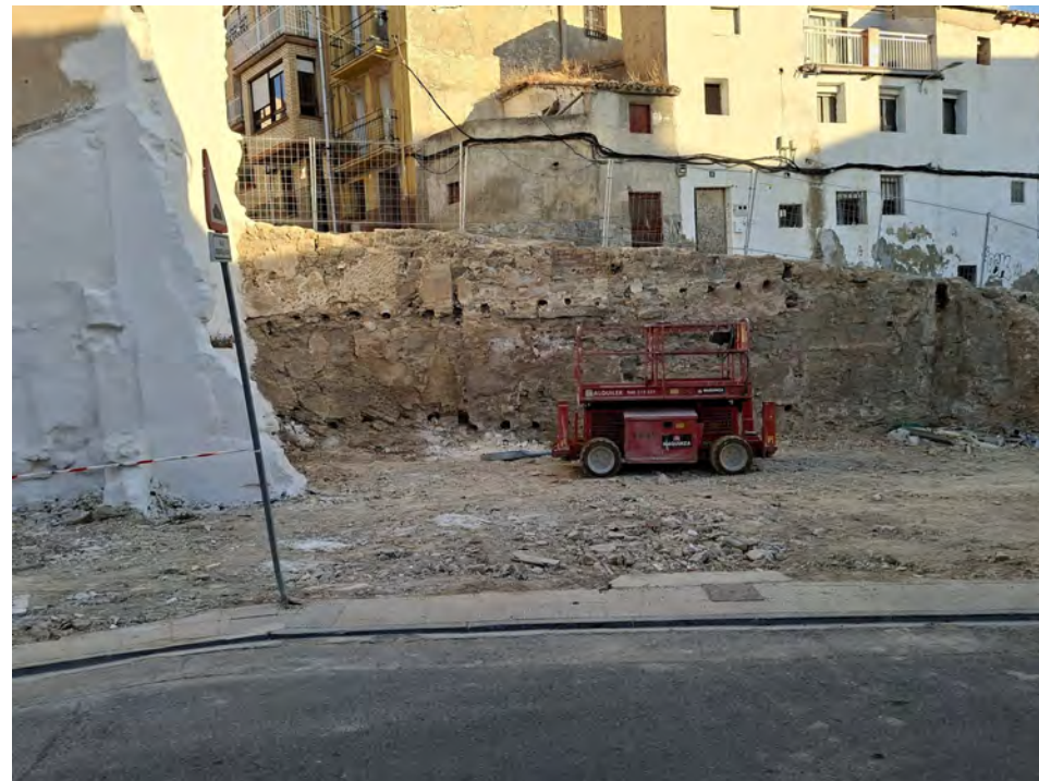
Estado en el que queda el solar, tras la demolición de las viviendas
