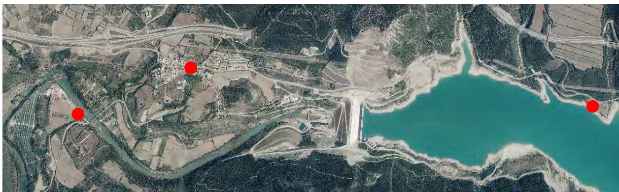
Figura nº3: Comparativa antes y después de la demolición de la urbanización náutica Leyre.
