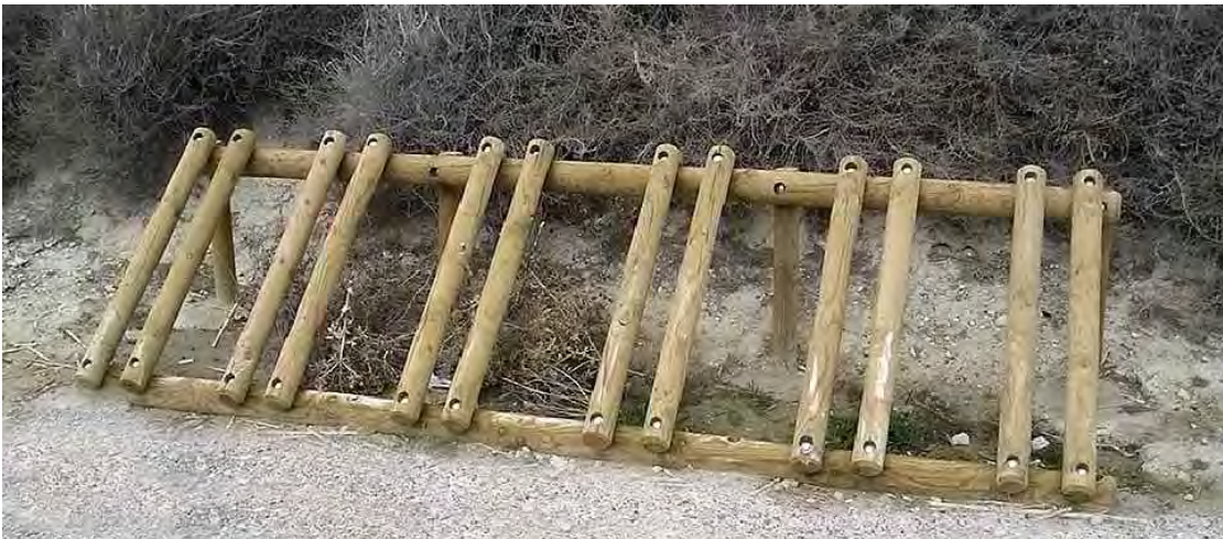
DETALLE APARCABICIS DE MADERA
