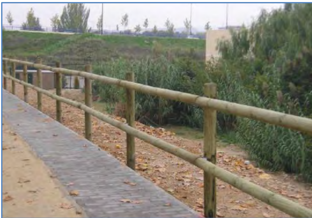
Figura nº 9: Detalle de barandilla rústica.
