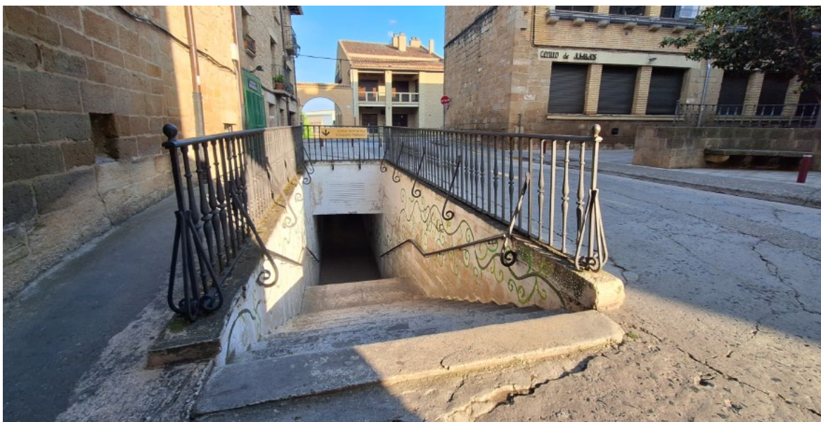
Vista frontal acceso a túnel
