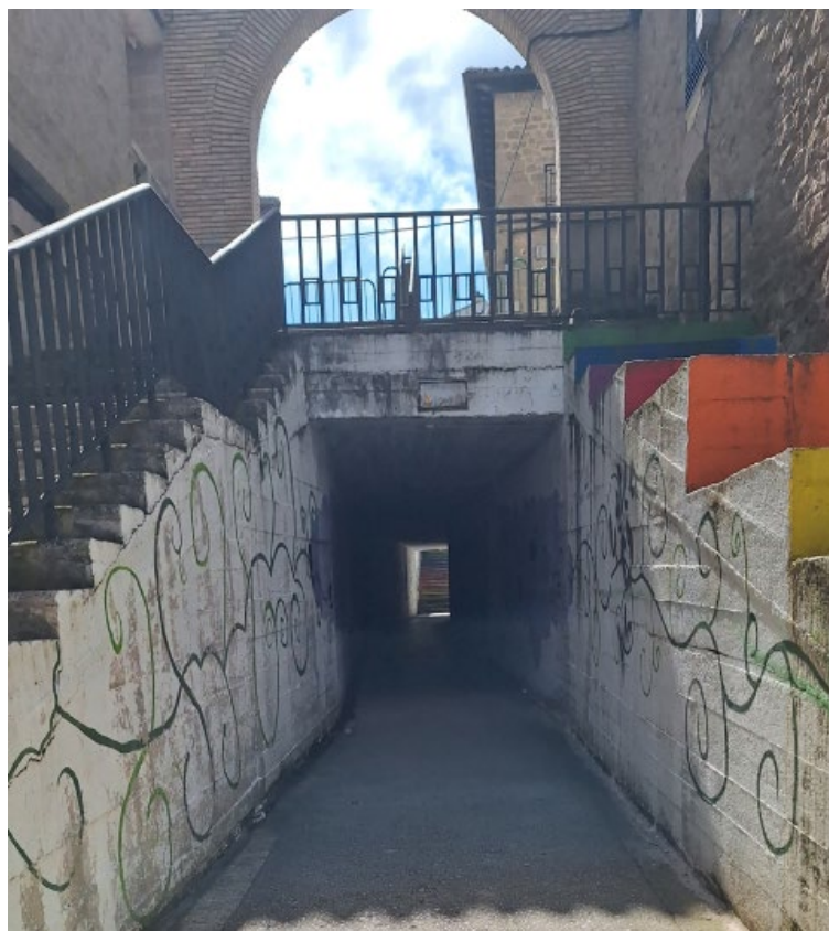
Final del túnel a Calle Pitillas
