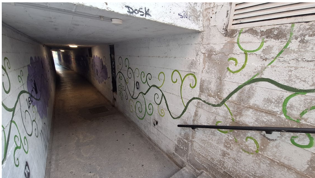
Interior túnel y vista Centro de Transformación soterrado (puerta acceso)
