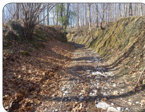
Tramo 1. Extrema pendiente y balasto calizo
