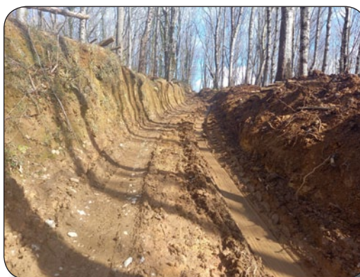
Tramo 2. Ascenso atrincherado y con calzada arcillosa
