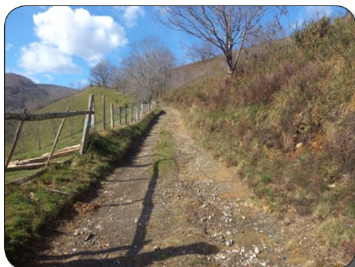
Tramo 2. Atrinchado con pradera aguas abajo
