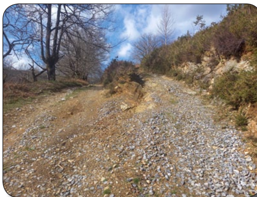
Tramo 3. Derivación a la dcha. en extrema pendiente
