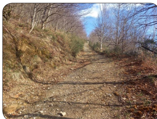
Tramo 6. Ascenso sin cuneta hacia Barazabalko Borda
