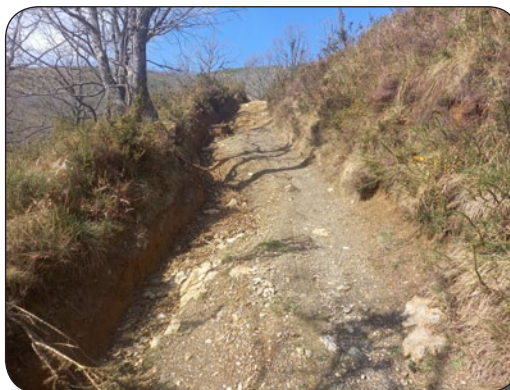
Tramo 3. Alteraciones casi intransitables
