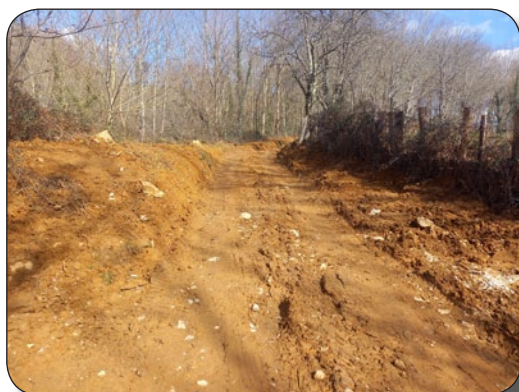
Tramo 1. Con cuneta
