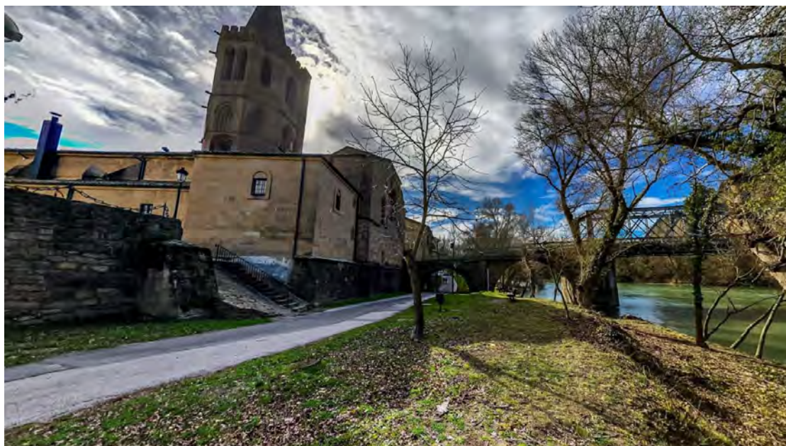
Pasarela Santa Maria la Real- zona centro:
