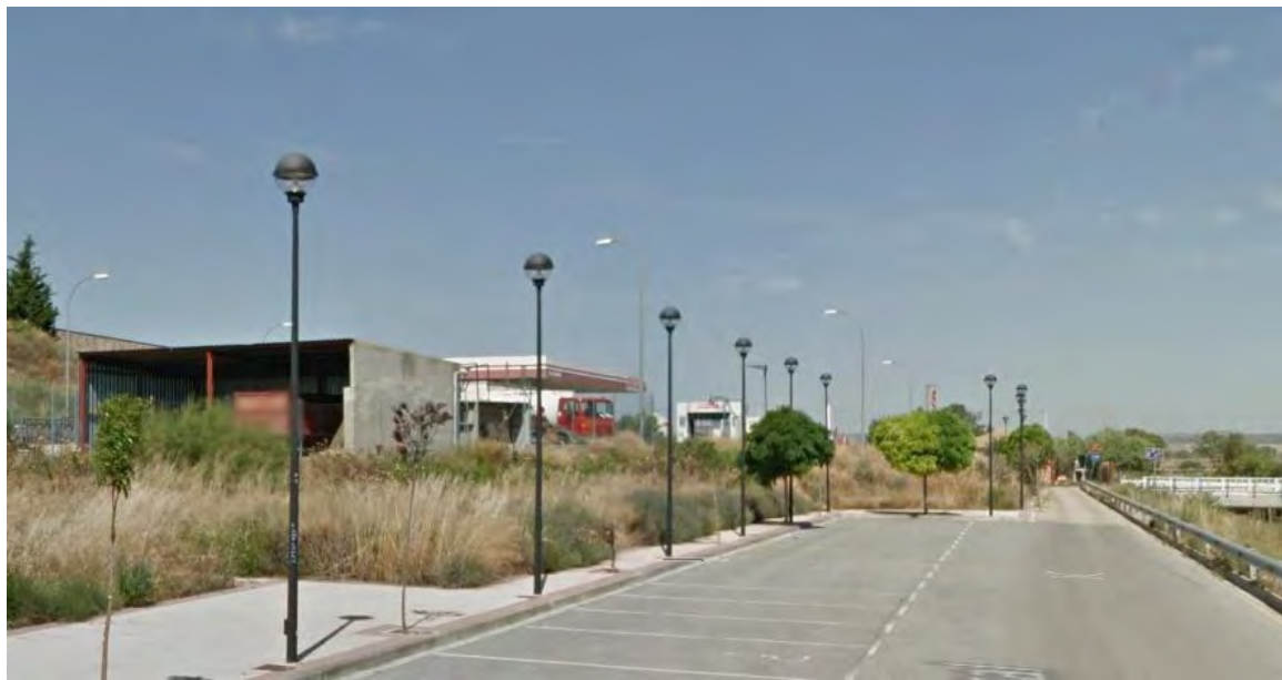
Luminarias VSAP 250 w en columna 10 m en la rotonda.
