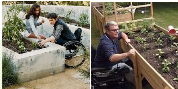
Obraen eraikiko dira. Elementu altuak, T formako hormigoi armatzuko oinarri hegaldua izango du gurpildun aulkientzako 75cm-ko hutsunea utziz; bere gainean 10cm-ko zurezko lorontzia kokatuko da. Elementu baxuak, hormigoi-blokeko perimetro izango du, enfoskatua. Altuera ezberdinetako lorontzi hauek lotuak egingo dira eta goikoaren urak, behekora jaitziko dira, ondoren guztiak modu jasagarrian parkeko zoruari bertan drenatuaz.
