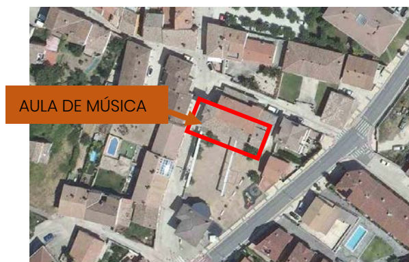
Imagen 1: Emplazamiento del edificio objeto de estudio.
