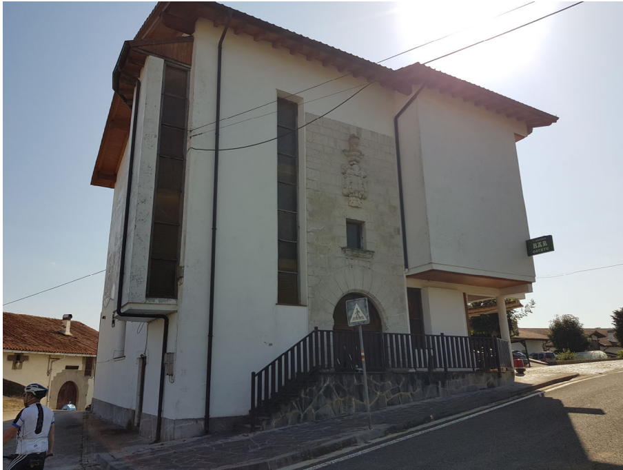
Imagen 03. Fachada lateral. Fachada suroeste.
