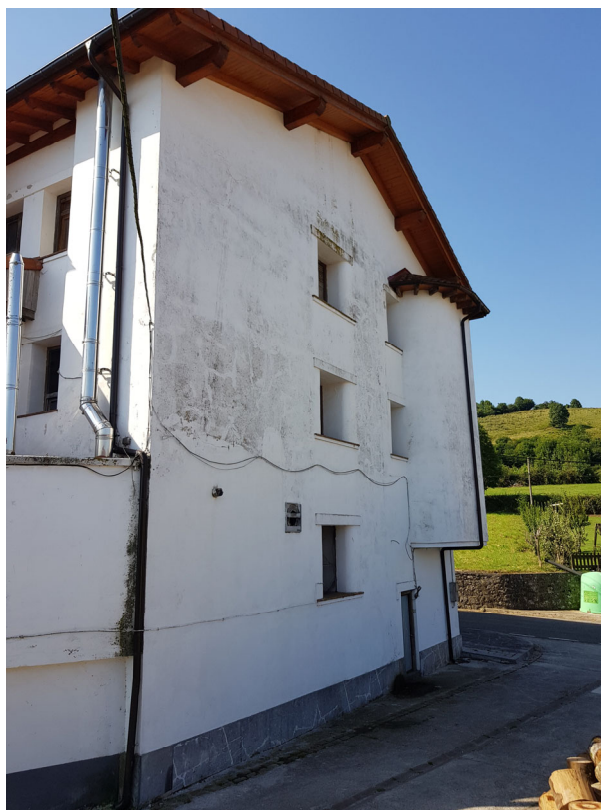
Imagen 02. Fachada trasera. Fachada noroeste.
