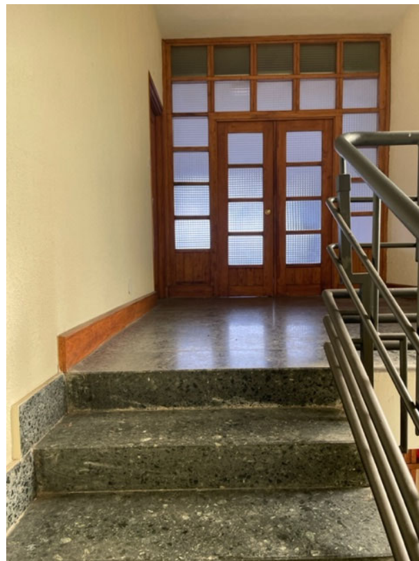
Imágenes 07 y 08. Zonas comunes de planta primera. Núcleo de escaleras.
