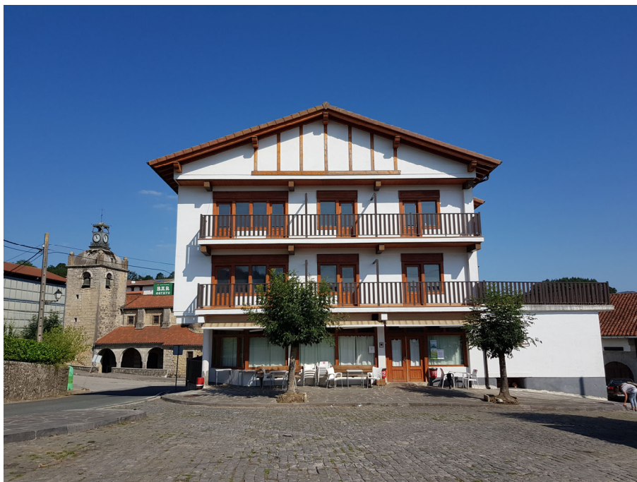
Imagen 01. Fachada principal. Fachada sureste.
