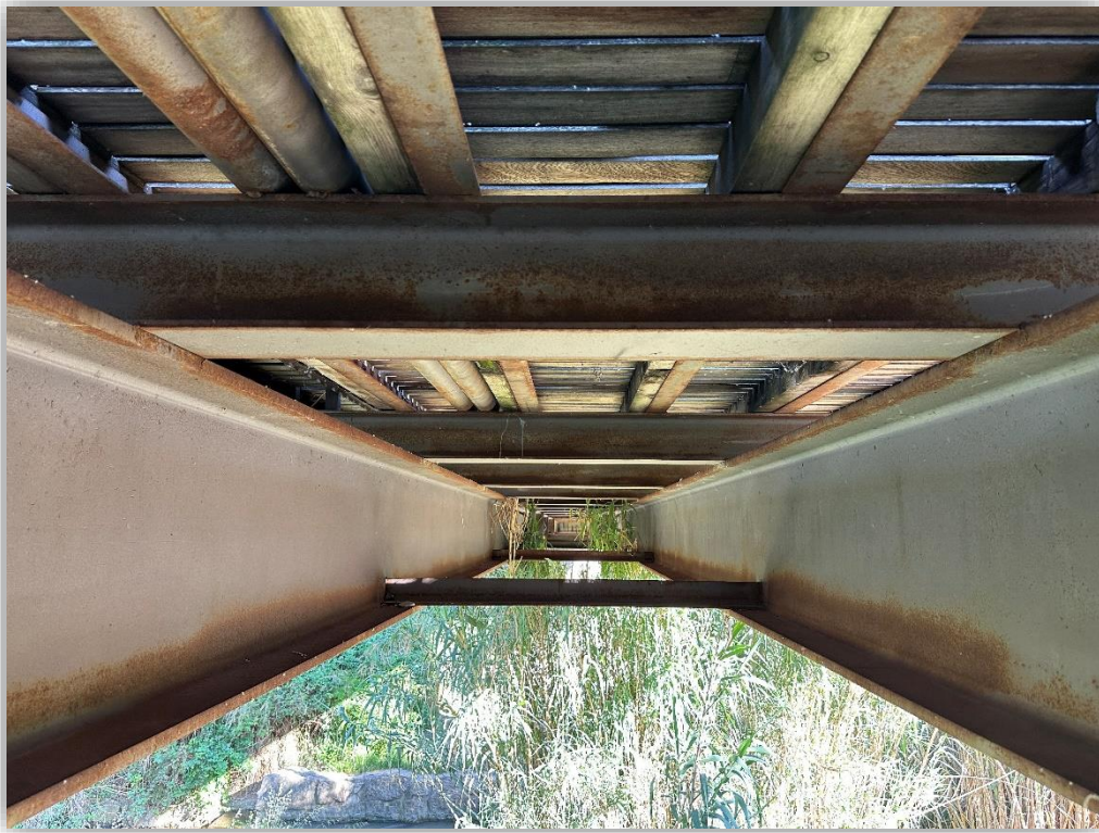
Fotografía 1 – Vista general vigas centrales con vigas transversales
