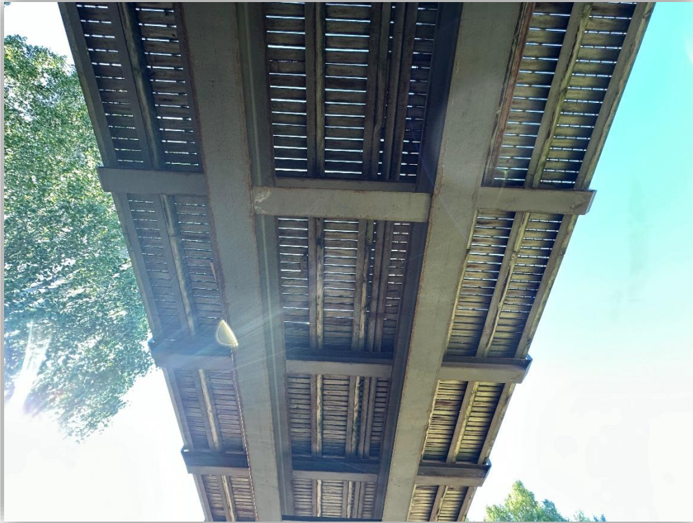
Fotografía 1 – Vista pavimento de madera del puente con vigas centrales y refuerzo de vigas
