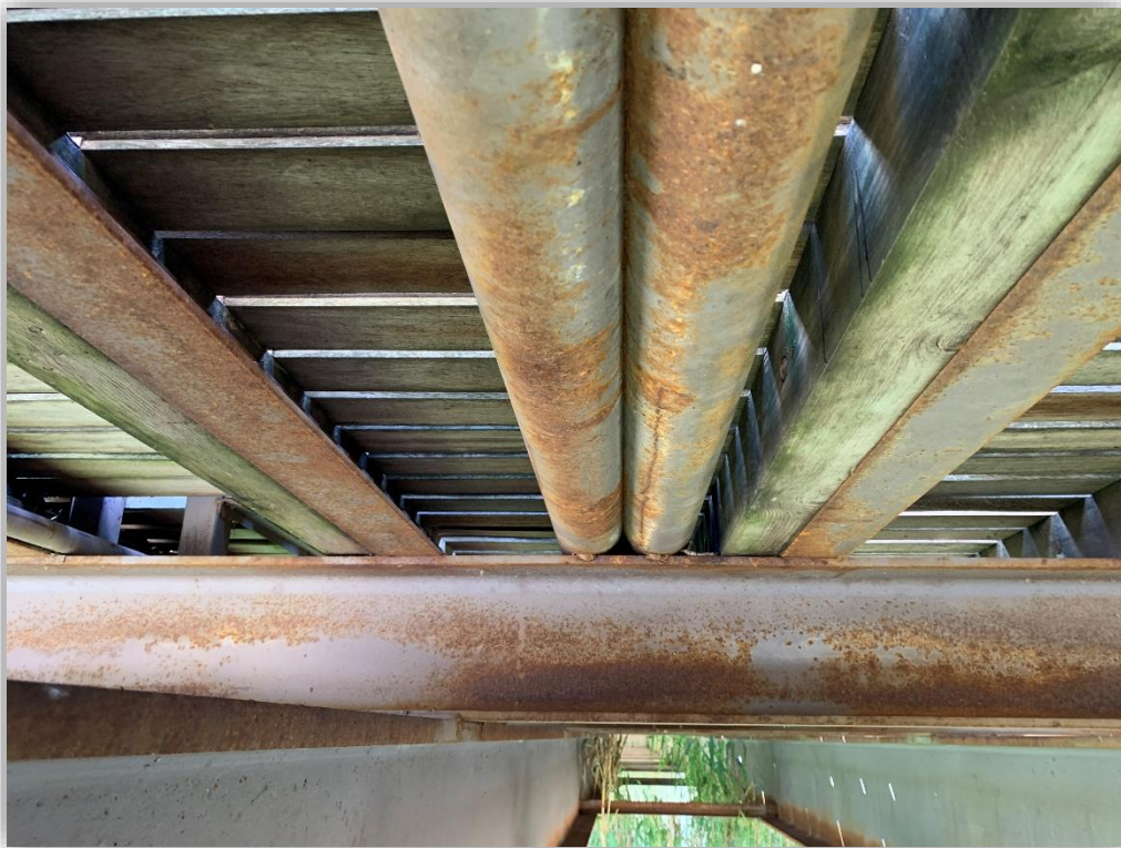
Fotografía 2 – Vista vigas de madera
