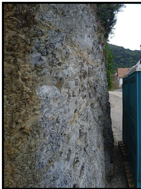
Imágenes 5 y 6: Afloramiento y taludes en roca observados
