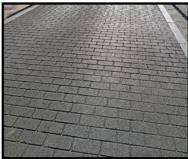
Detalle del pavimento de asfalto impreso
