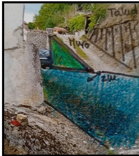
Imagen 16: Croquis sobre fotografía del muro y la excavación
