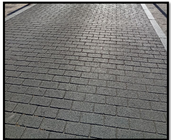
Imagen 19: Detalle del pavimento de asfalto impreso en una calle de Elorrio (Bizkaia)
