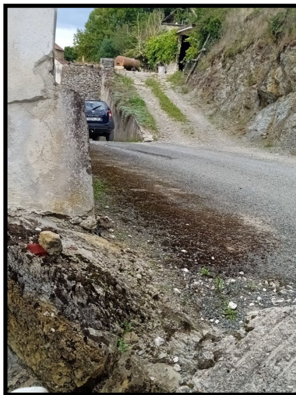
Imágenes 7 y8: Afloramiento y taludes en roca observados
