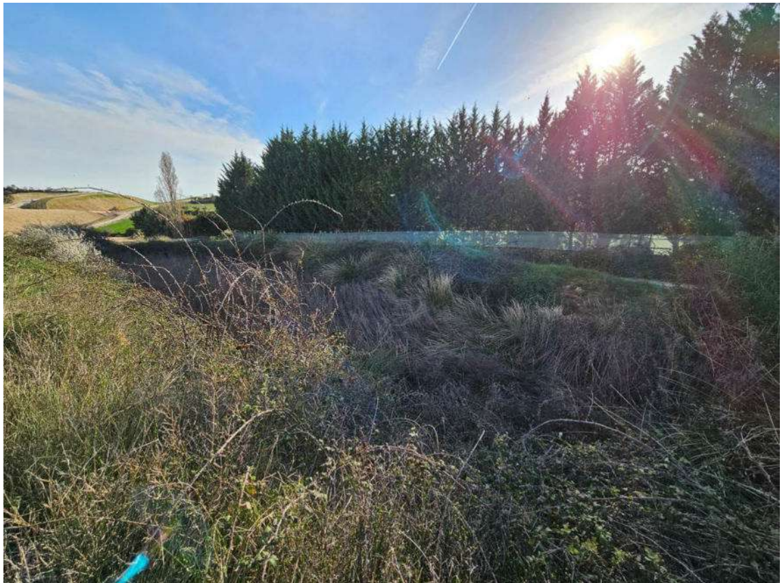
Fotografía de la Balsa La Pedrera
