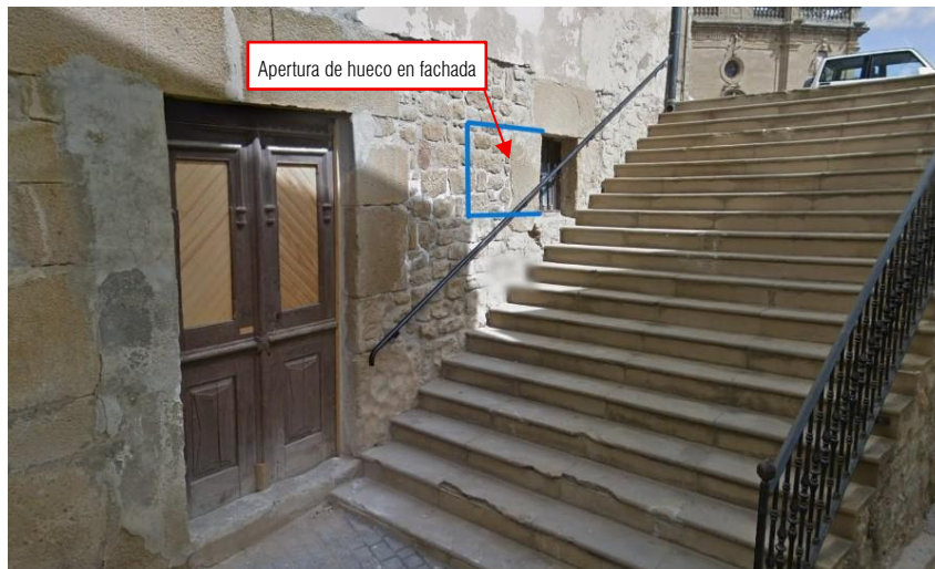
Imagen 4. Fachada de almacén de planta sótano
